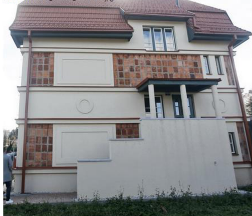
Obrázek č. 26 a 27 – postranní pohled a pohled na štít - https://www.idnes.cz/jihlava/zpravy/jihlava-orohlidka-dny-architektury.A180929_171439_jihlava-zpravy_bse/foto/BSE765a6c_224827_112806z2.jpg
