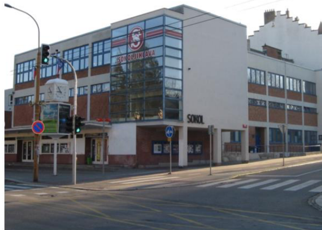
Obrázek č. 40 - Sokolovna s tělocvičnou a kinem Jihlava - současný stav - http://www.sokolskepamatky.eu/objekty/detail/sokolovna-jihlava/
