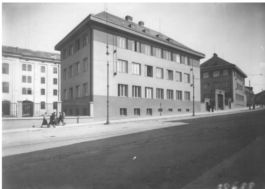
Vstup do přádelny a apretury Johanna Tosta / Tabákové továrny / Tesly, architekt: Karel Rošník, realizace 1931–1934, fotografie nedatována, zdroj: Muzeum Vysočiny, fond Fotoarchiv města Jihlavy.
