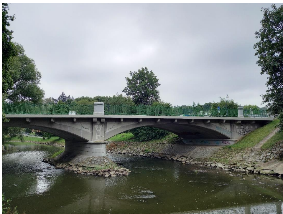
Dnešní podoba mostu U Jánů, zdroj fotografie: terénní průzkum Marie Novákové (2022).
