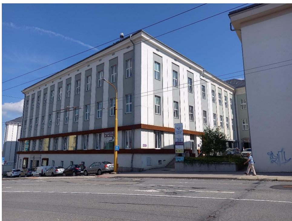
Dnešní podoba komplexu budov Jihlavské terasy, zdroj fotografie: terénní průzkum Marie Novákové (2022).
