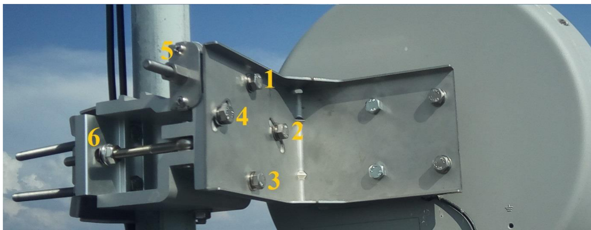
Obr. 4.13: Jemné doladění rádia s vyznačenými šrouby
