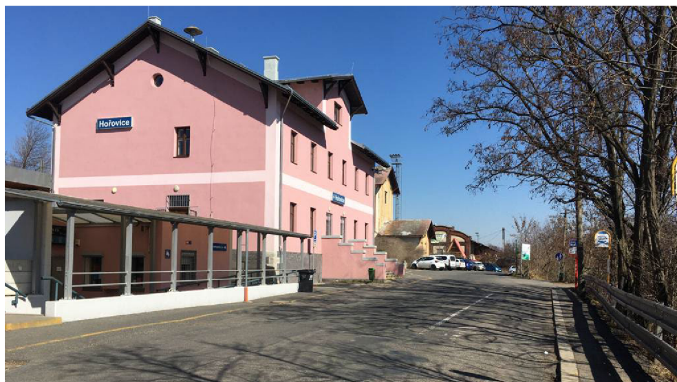
Obrázek 59 Chybějící chodníky a přechody před nádražím (autor: Jan Michalica)
