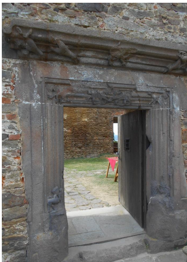
Obr. 2 Vstupní portál Trčkovského paláce kombinuje ve svém uměleckém provedení pozdně gotické a renesanční prvky, foto autor 2018.
