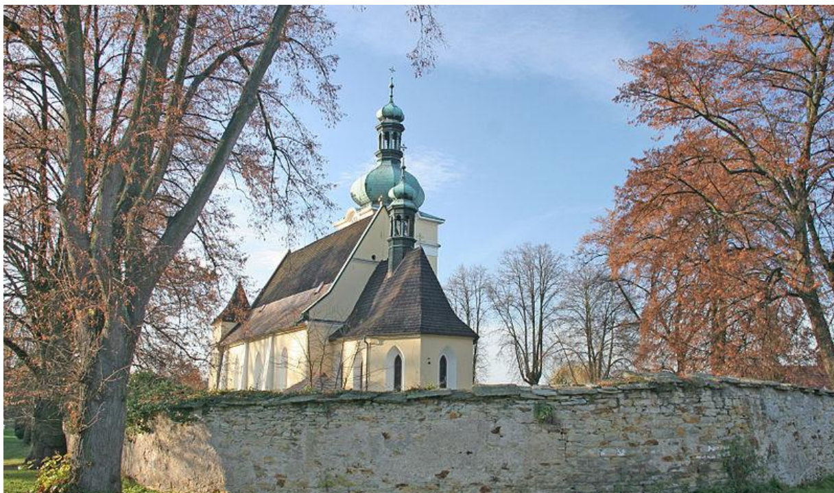
Obr. 44 Celkový pohled na kostel sv. Prokopa od jihovýchodu. Reprodukce z: Wikimedia Commons, File:Přepychy - kostel sv. Prokopa.JPG [online], [cit. 2019-03-28], Dostupné z: https://commons.wikimedia.org/wiki/File:Přepychy_-_kostel_sv._Prokopa.JPG .
