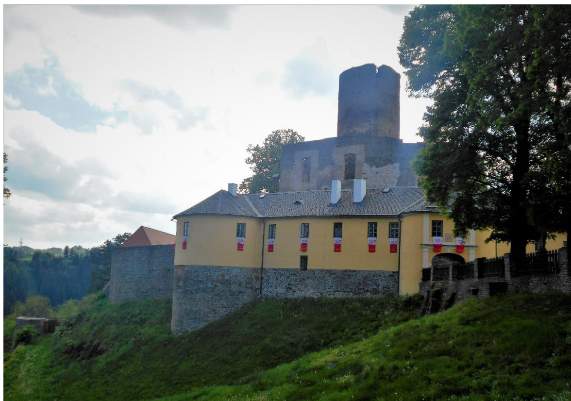
Obr. 23 Pohled na čelo hradu Svojanov s obvodovým zdivem Trčkovského paláce před obranným břitem bergfritové věže, kterou palác z velké části zastínil, foto autor 2015.
