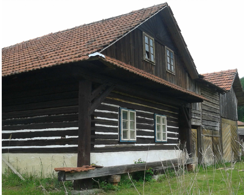
Obr. 1 Roubená stavba – usedlost v Lubné u Litomyšle
