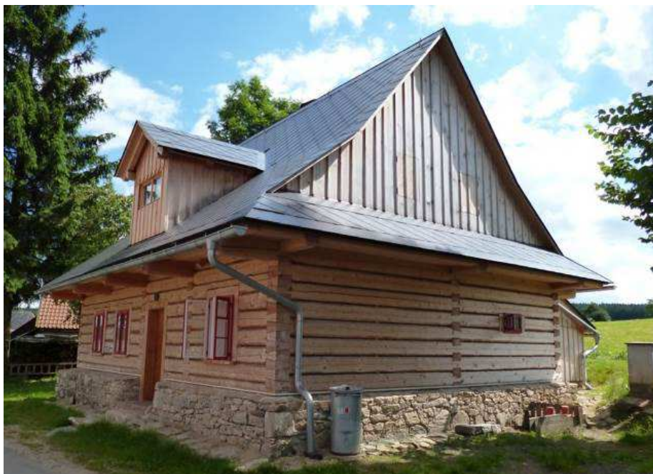
Obr. 8 Novostavba roubenky, obec Kadov
