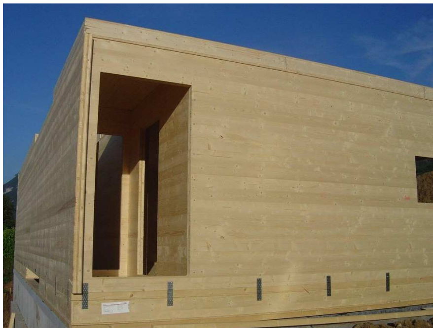
Obr. 9 Panelová konstrukce z masivu [39]
