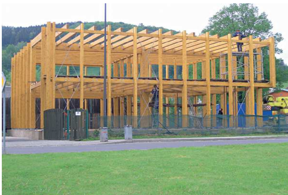
Obr. 7 Skeletový systém z lepeného lamelového dřeva [19]
