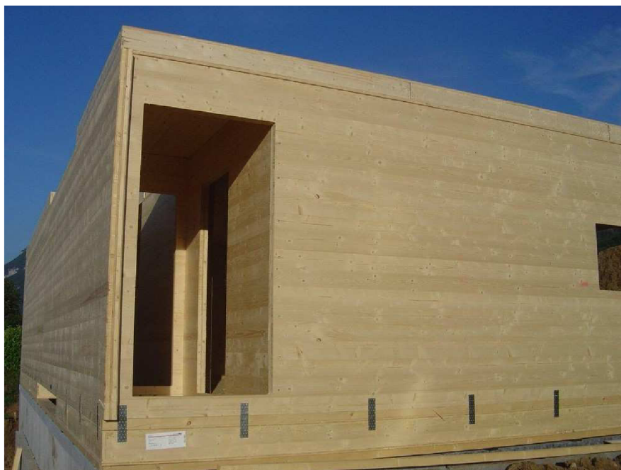
Obr. 9 Panelová konstrukce z masivu [39]
