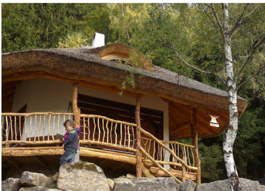
Obr. 10 Novostavba domu ze slámy s roubením, obec Podlesí
