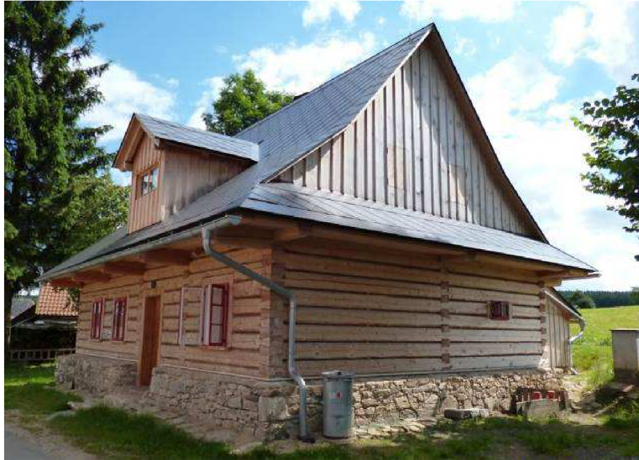
Obr. 8 Novostavba roubenky, obec Kadov
