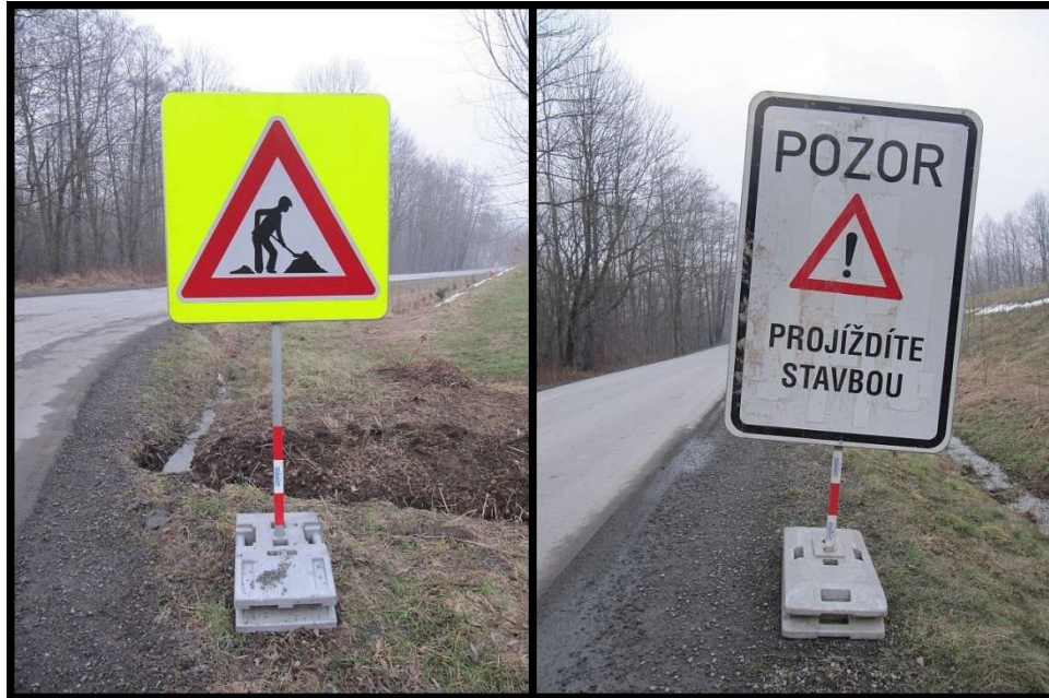
Obr. 2 – Přechodné dopravní značení přenosné
