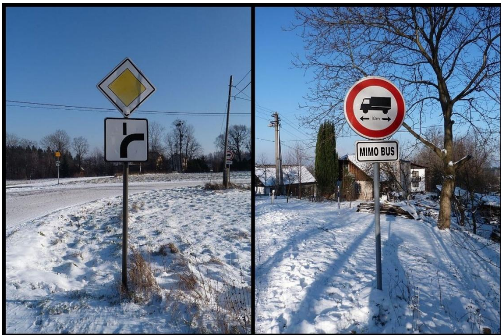
Obr. 1 – Stálé dopravní značení svislé
