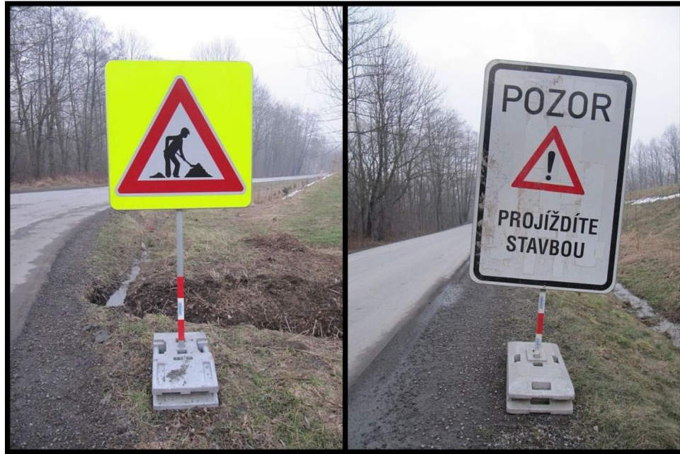
Obr. 2 – Přechodné dopravní značení přenosné
