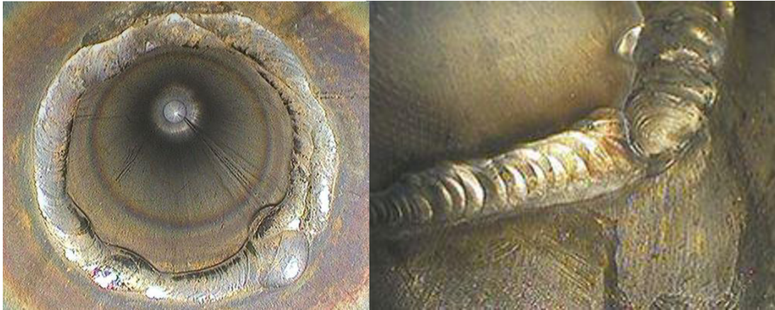
obr. 1.6. Kontrola zvarového spoja pomocou videoskopov [9], [10]
