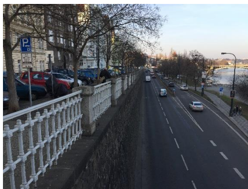
Foto č. 13.: Ulice Hořejší nábřeží
