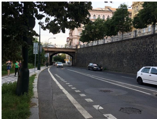
Foto č. 26.: Nábřežní zeď, Hořejší nábřeží
