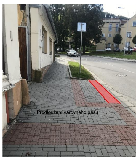
Obrázek 194 Nevhodné provedení varovného pásu
