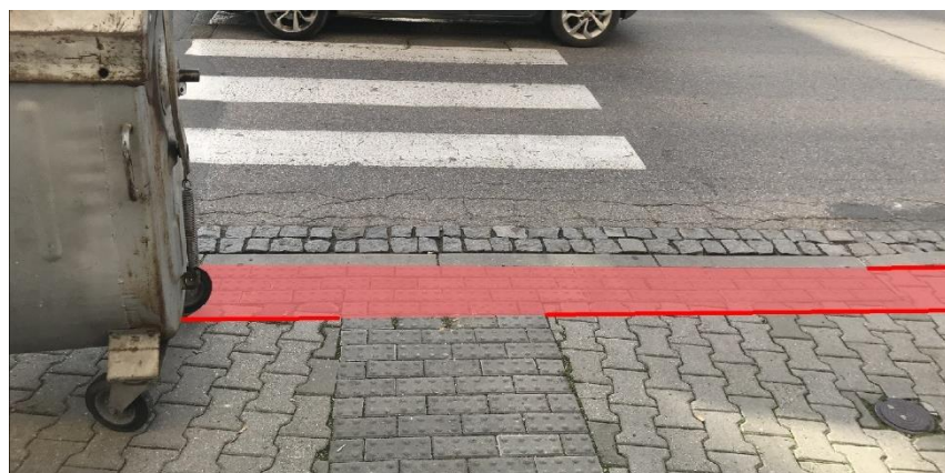
Obrázek 233 Rozšíření a prodloužení varovného pásu
