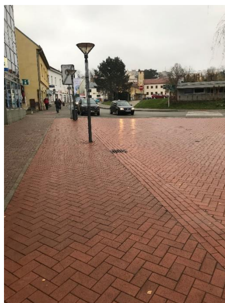
Obrázek 167 Chybějící vodící linie
