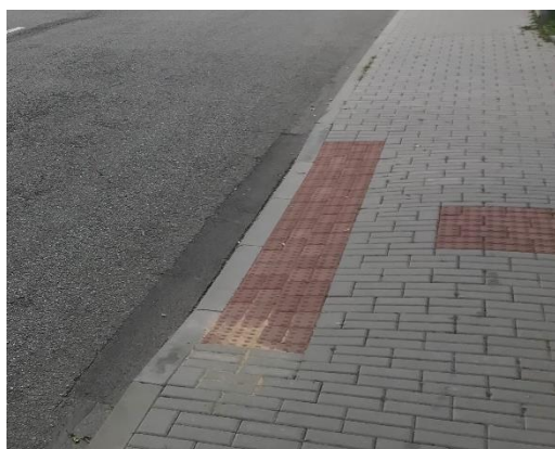
Obrázek 26 Varovný pás místa pro přecházení
