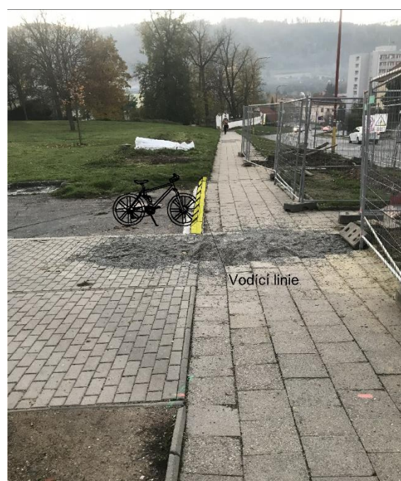
Obrázek 273 Doplněná vodící linie
