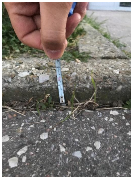
Obrázek 85 Nedostatečná výška vodící linie
