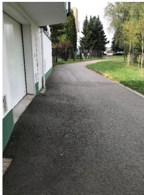
Obrázek 187 Chybějící vodící linie
