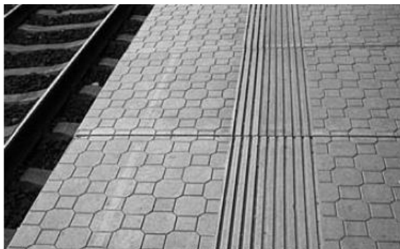
Obrázek 29 Vodící linie s funkcí varovného pásu [4]
