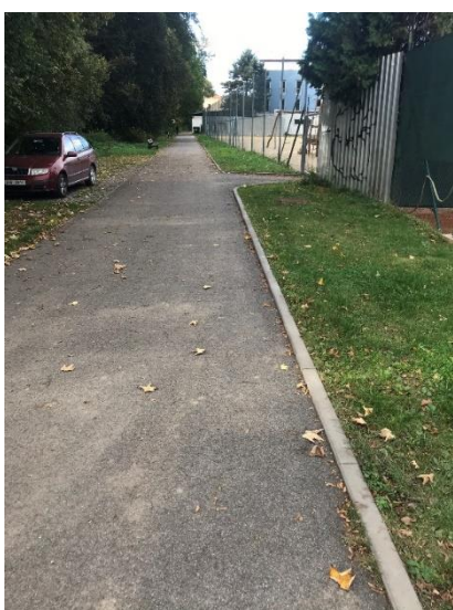
Obrázek 202 Nepředpisová výška vodící linie
