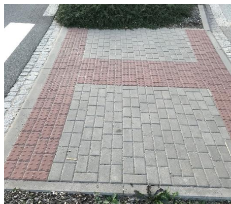
Obrázek 25 Varovný pás přechodu pro chodce
