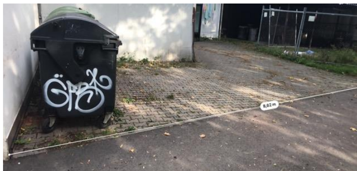
Obrázek 203 Chybějící vodící linie
