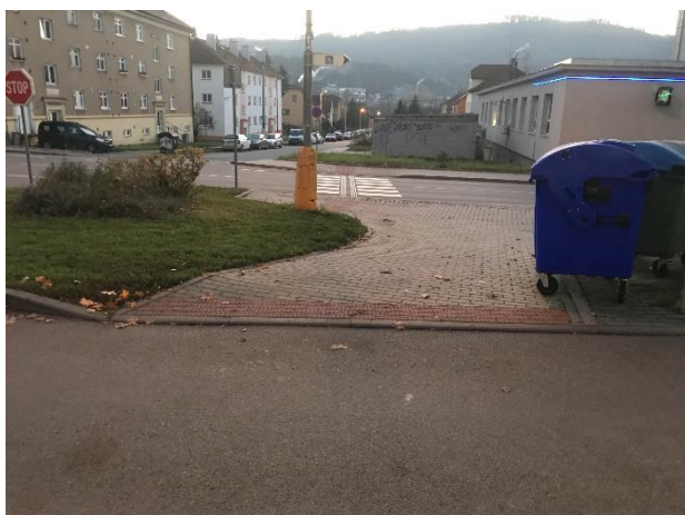
Obrázek 286 Chybějící hmatné prvky
