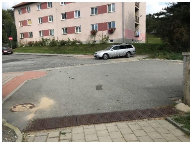
Obrázek 90 Konec pěší zóny u výjezdu ze stadionu bez přímé návaznosti na chodník pro chodce
