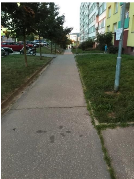
Obrázek 84 Vodící linie nedostatečné výšky a zarostlá zelení
