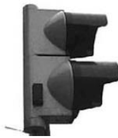
Akustická signalizace na přechodu
