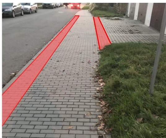
Obrázek 289 Vjezd ke garážím
