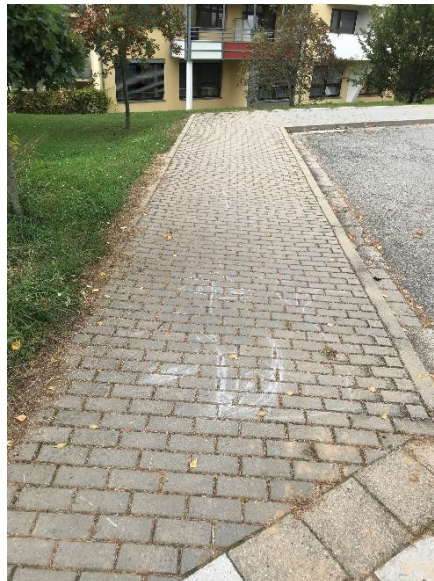
Obrázek 123 Chybějící vodící linie
