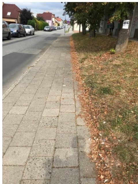
Obrázek 102 Zanesená vodící linie
