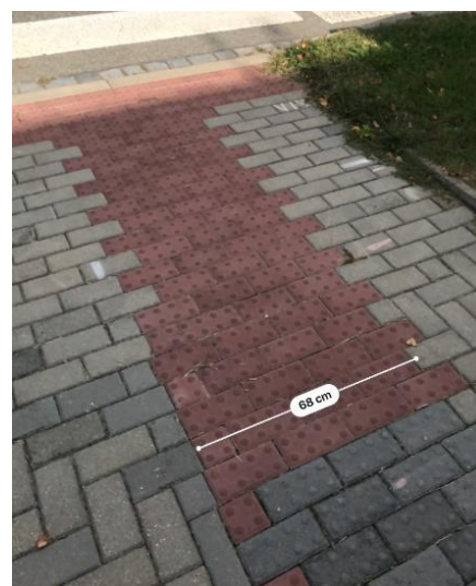
Obrázek 119 Špatné řešení signálního pásu
