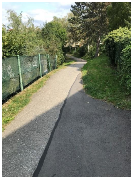
Obrázek 130 Chybějící vodící linie
