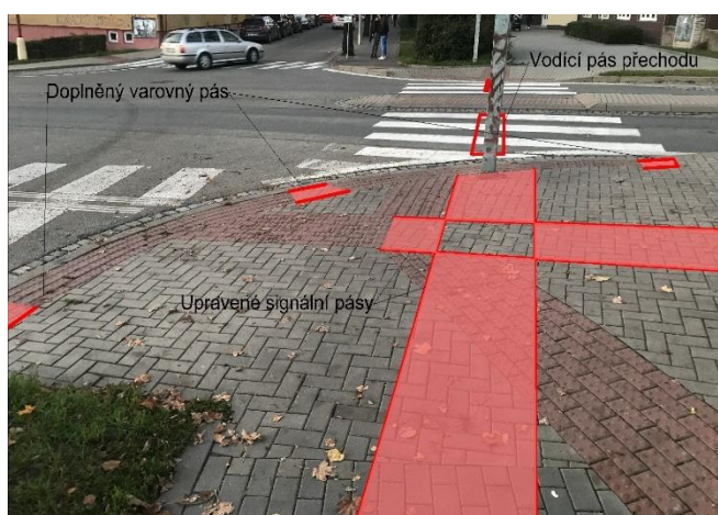
Obrázek 280 Nevhodné řešení signálních pásů
