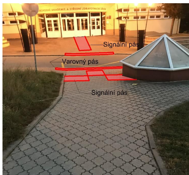
Obrázek 87 Nízká vodící linie a chybějící bezbariérové prvky
