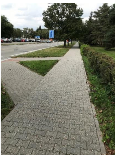
Obrázek 178 Chybějící vodící linie a signální pásy
