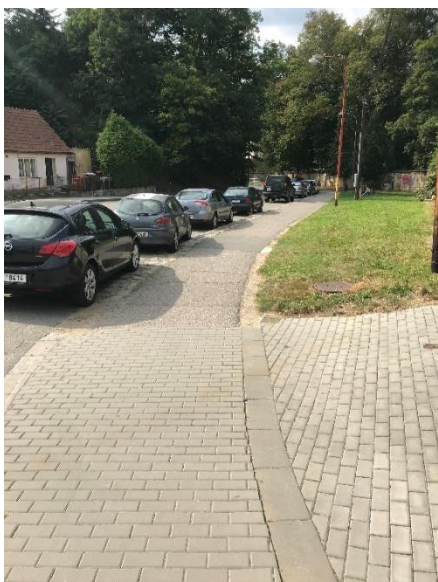
Obrázek 152 Chybějící vodící linie a varovný pás
