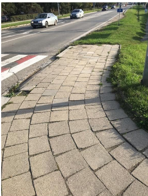
Obrázek 216 Chybějící bezbariérové prvky, špatný technický stav chodníku
