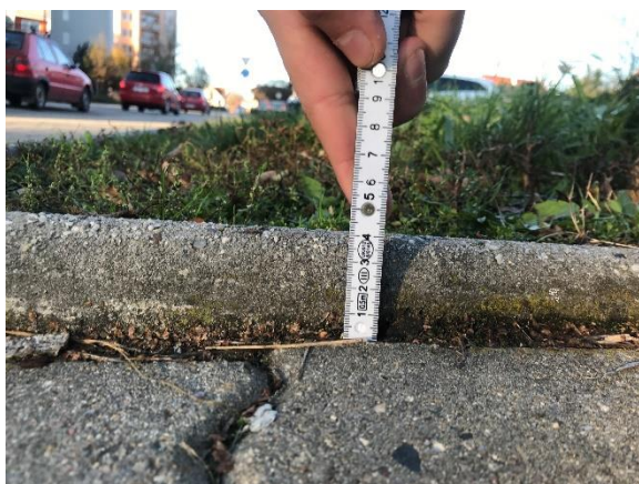
Obrázek 235 Nedostatečná výška vodící linie
