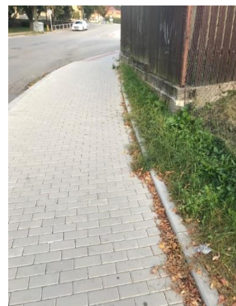
Obrázek 62 Zanesená vodící linie
