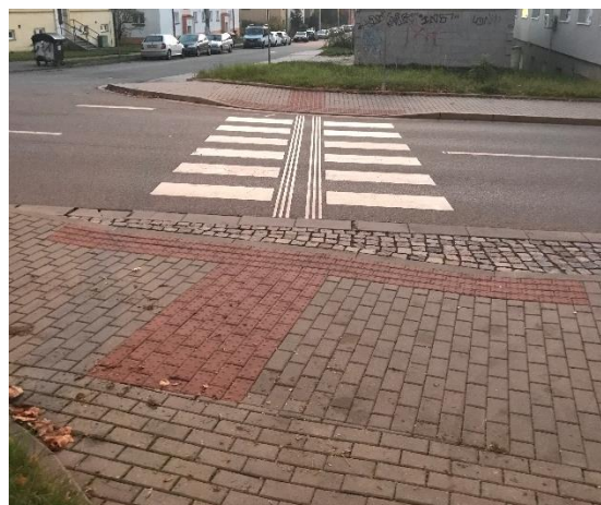
Obrázek 285 Špatně provedený signální pás
