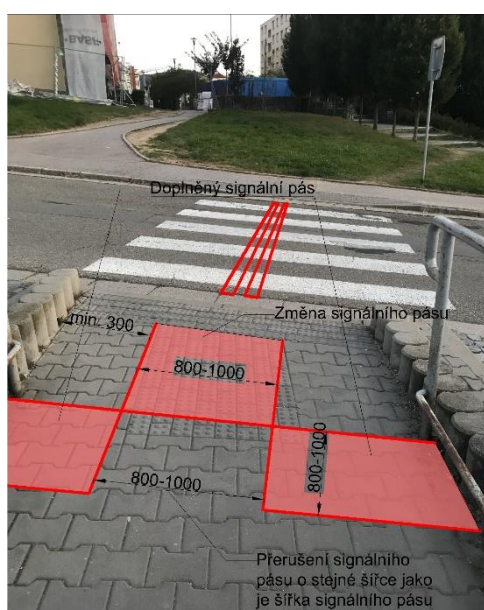
Obrázek 79 Úprava signálního pásu, Vodící pás přechodu
