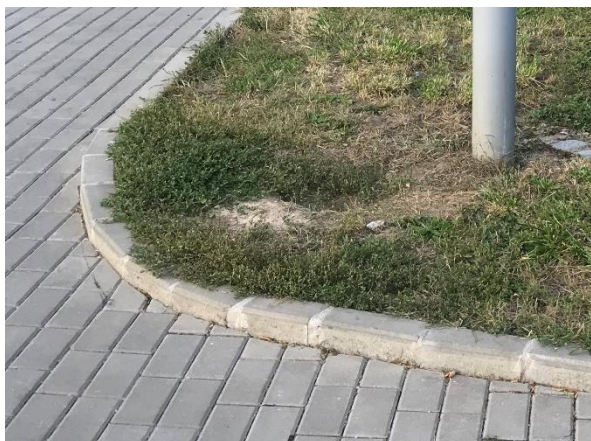
Obrázek 14 Přirozená vodící linie – obrubník trávníku min. 60 mm
