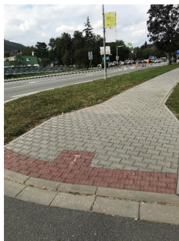
Obrázek 175 Nevhodná délka signálního pásu
