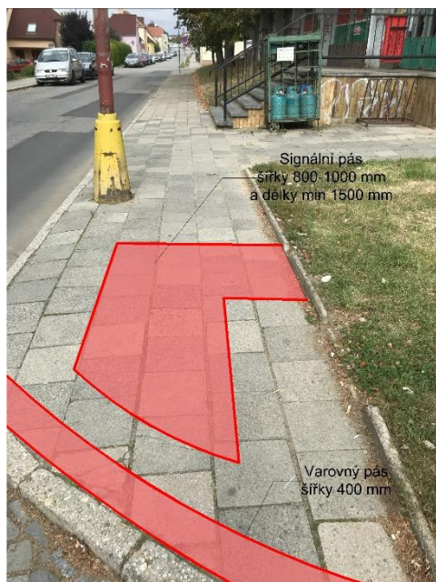
Obrázek 101 Vodící linie ve špatném stavu
