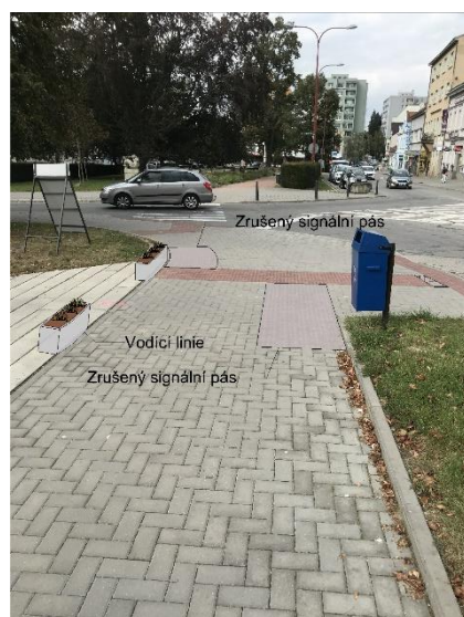
Obrázek 156 Špatně řešené signální pásy
