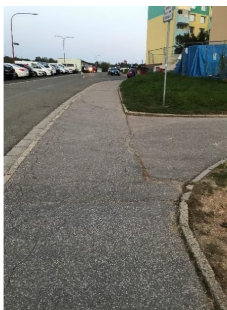
Obrázek 80 Vodící linie nedostatečné výšky
