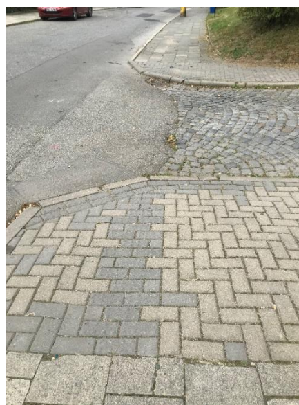
Obrázek 104 Nevyhovující varovný a signální pás
