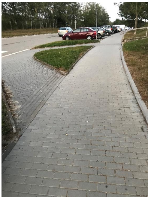
Obrázek 77 Zbytečný varovný pás
