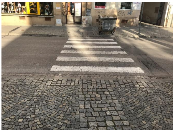
Obrázek 230 Nášlapem obtížně rozeznatelné povrchy
