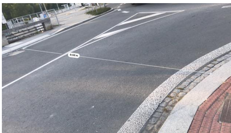
Obrázek 52 Trasa přecházení delší než 8000 mm
