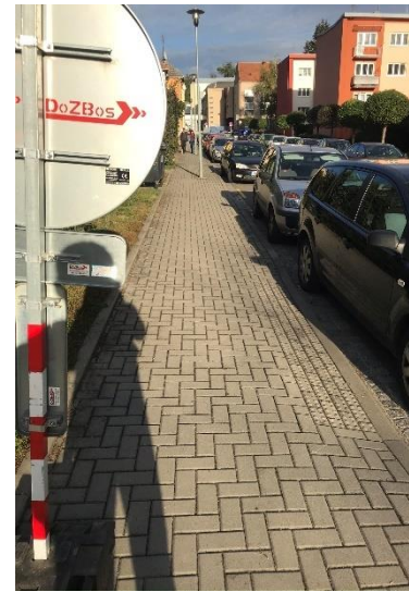
Obrázek 221 Překážky v cestě
