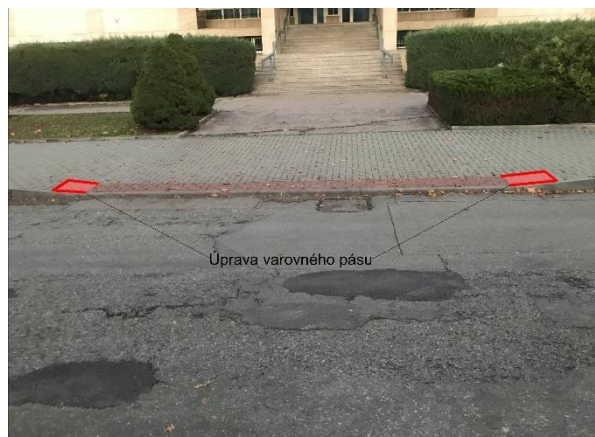
Obrázek 282 Varovný pás u budovy soudu
