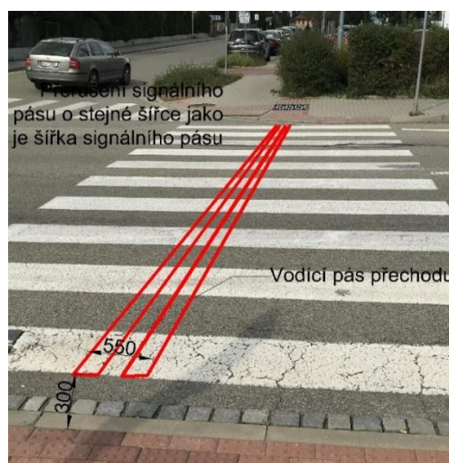
Obrázek 110 Chybějící vodící pás přechodu
