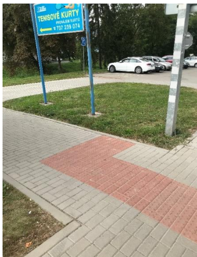
Obrázek 183 Chybějící vodící linie
