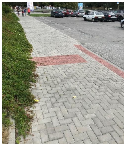
Obrázek 158 Zeleň rostoucí přes vodící linii
