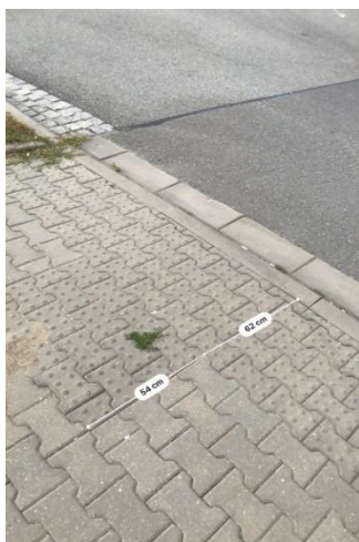
Obrázek 177 Nevhodná délka signálního pásu, nekонтastní materiály
