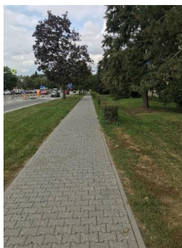
Obrázek 180 Chybějící signální pásy
