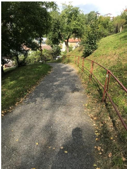
Obrázek 133 Chybějící vodící linie a zarážka pro bílou hůl
