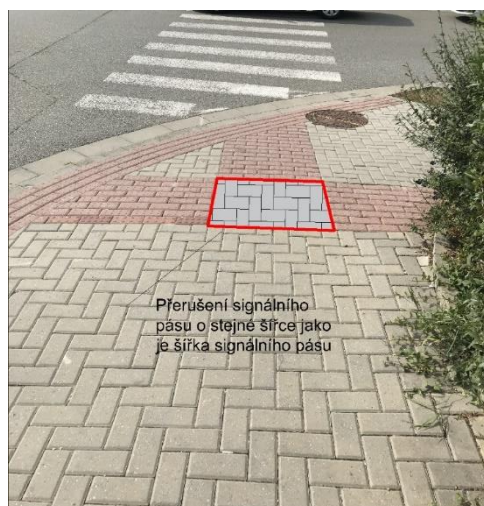
Obrázek 124 Špatné řešení signálního pásu
