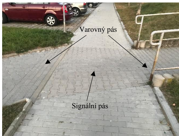
Obrázek 76 Nekontrastní a nesmyslně umístěné prvky
