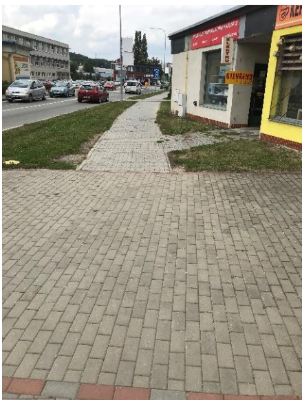
Obrázek 171 Chybějící vodící linie
