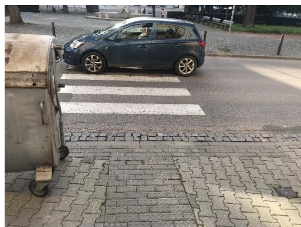
Obrázek 229 Nevyhovující varovný pás
