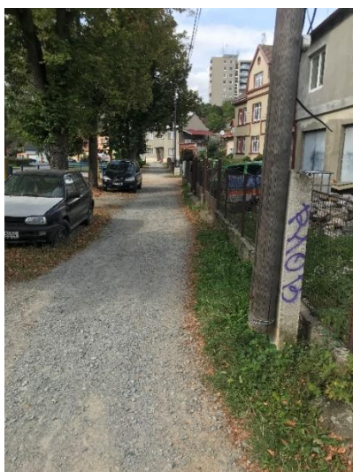
Obrázek 143 Chybějící vodící linie
