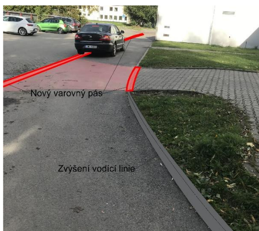
Obrázek 205 Vjezd na parkoviště přes pěší zónu
