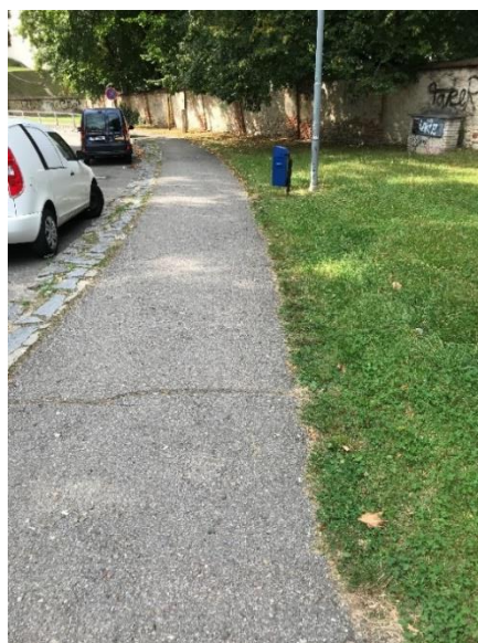
Obrázek 151 Chybějící vodící linie a nepředpisový varovný pás
