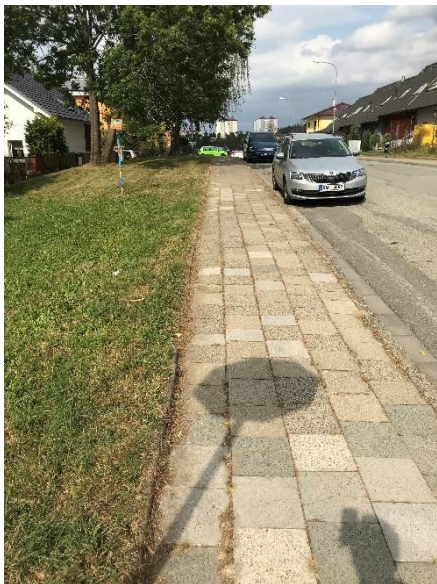
Obrázek 122 Nedostatečná výška vodící linie
