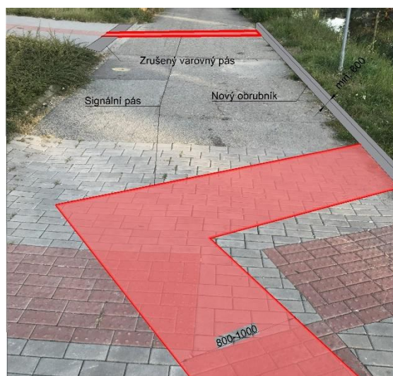
Obrázek 55 Nepředpisové napojení signálních pásů, vodící linie zarostlá zelení
