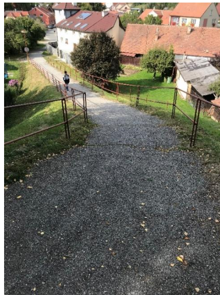
Obrázek 134 Chybějící vodící linie a zarážka pro bílou hůl
