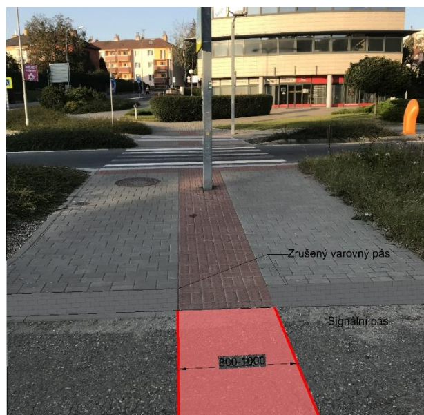
Obrázek 57 Signální pás bez vodící linie, zbytečný varovný pás
