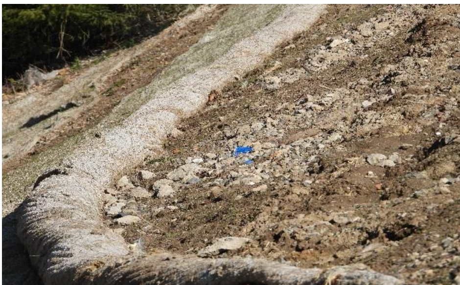
Obrázek 17: Srolovaná geotextilie D1 km 60,5 (zdroj Kozák 2020)
