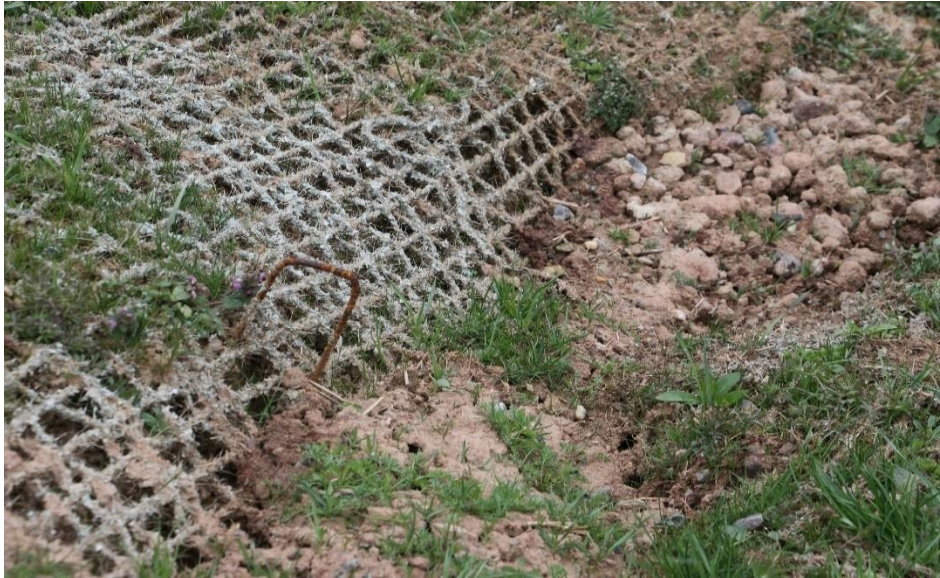
Obrázek 12: Vysunutá kotva, erozní rýha (zdroj Kozák 2021)
