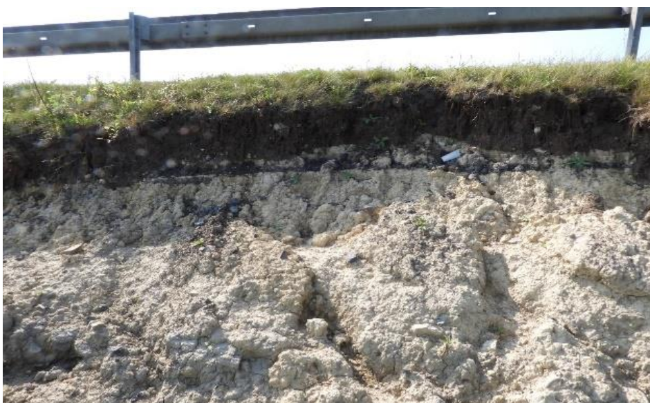
Obrázek 23: Odkrytý vyvápňený substrát D8 km 49,3 (zdroj Kozák 2021)
