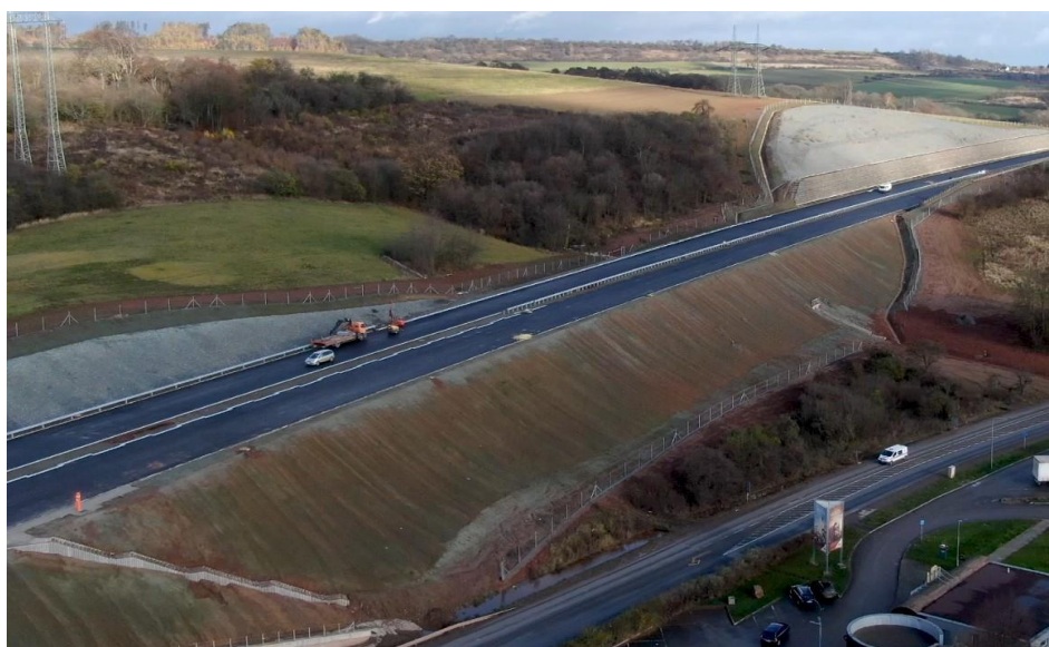
Obrázek 7: Letecký pohled na těleso dálnice D6 km 41,300 (evidence ŘSD 2020)
