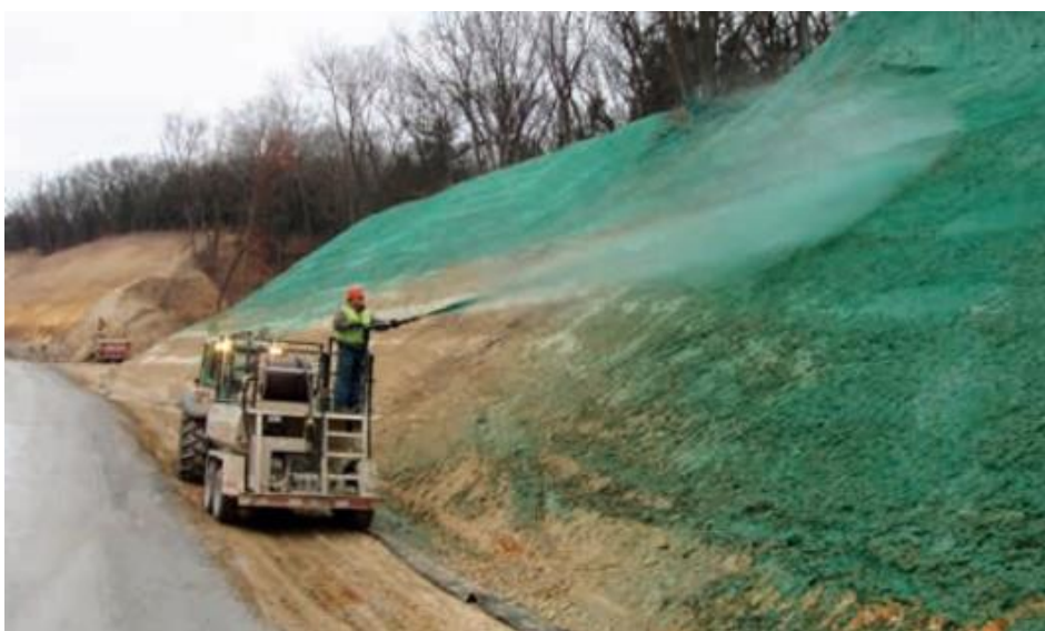
Obrázek 4: Realizace hydroseivu na svah PK (Zlatuška 2020)
