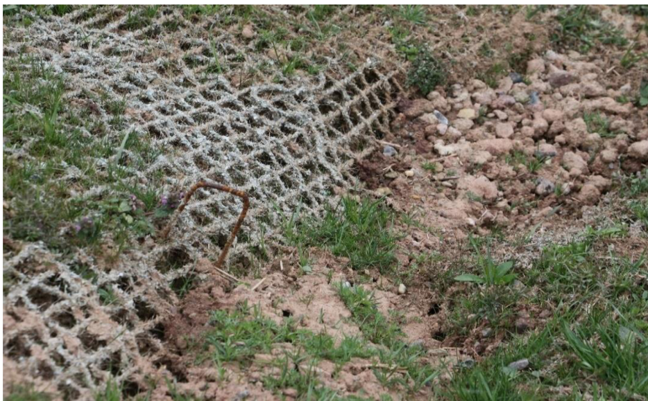
Obrázek 12: Vysunutá kotva, erozní rýha (zdroj Kozák 2021)
