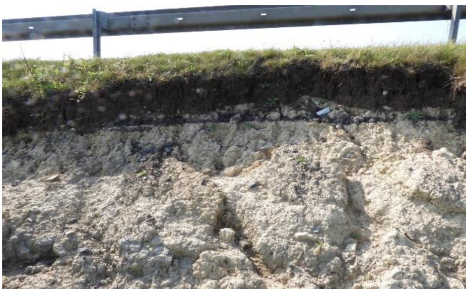
Obrázek 23: Odkrytý vyvápňený substrát D8 km 49,3 (zdroj Kozák 2021)
