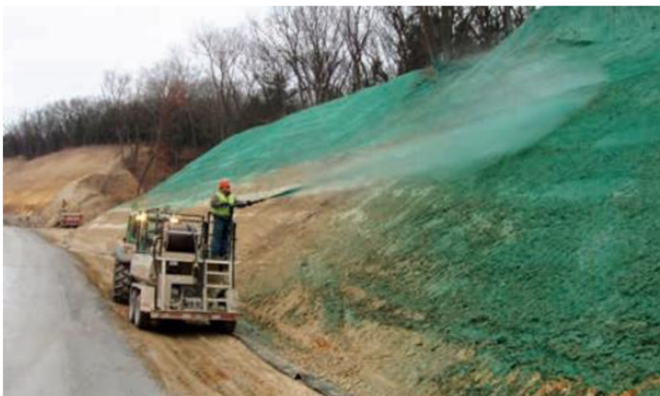
Obrázek 4: Realizace hydroseivu na svah PK (Zlatuška 2020)
