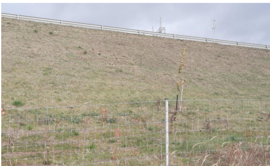
Obrázek 14: Násyp v km 41,300 současný stav (zdroj vlastní 2023)
