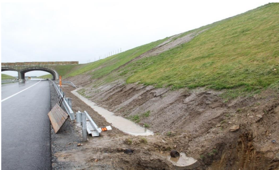
Obrázek 29: Zvodnělý svah zářezu D3 km 90,9 (zdroj Kozák 2013)
