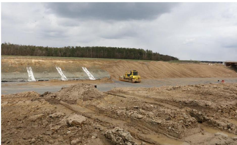
Obrázek 27: Výstavba drenážních žeber na svahu D11 km (zdroj Kozák 2021)
