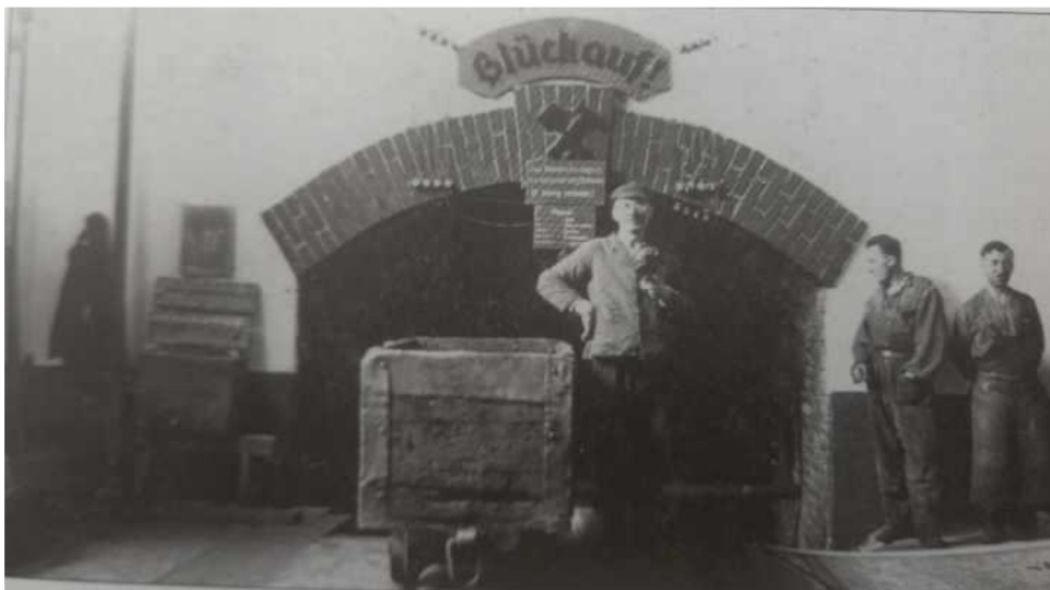
Obr. 3 Štola Ida ve Rtyni v Podkrkonoší (Zdroj: Zdař Bůh.cz, 2015)
