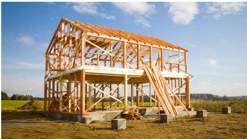
Obr. 27) Rámová nosná konstrukce dřevostavby [38]
