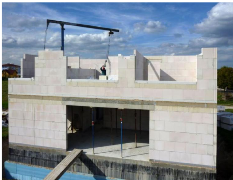
Obr. 23) Strojní zdění hrubé stavby pomocí minijeřábu [35]
