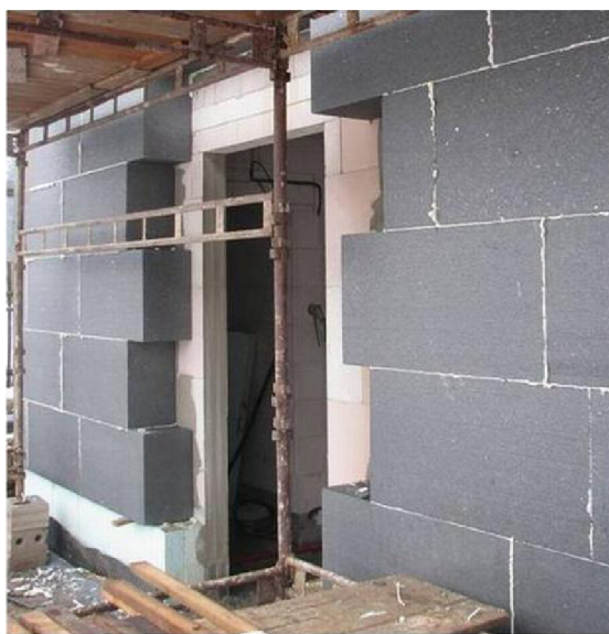
Obr. 24) Vápenopísková cihla a šedý EPS lepený celoplošně [36]
