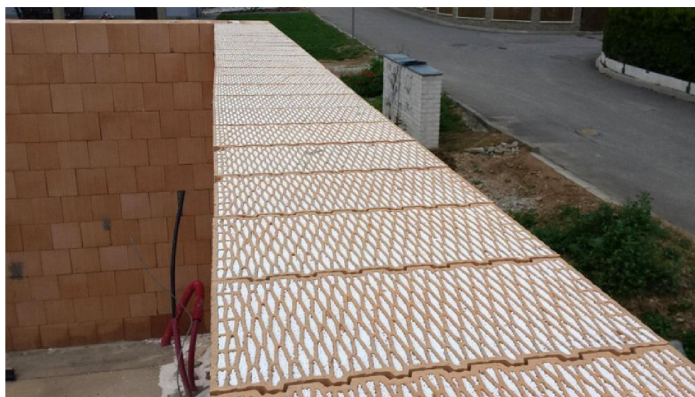
Obr. 19) Zdění ze systému Heluz [29]
