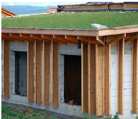
Obr. 25) Vápenopísková cihla a I nosníky [36]
