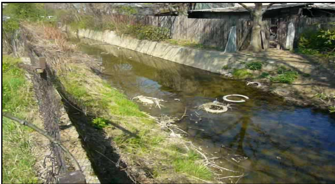
(Obr. 7.12. Tvrdě opevněné koryto ve Všehrdech ř. km 2,049 - Petr Bujdák, 03/2011).
