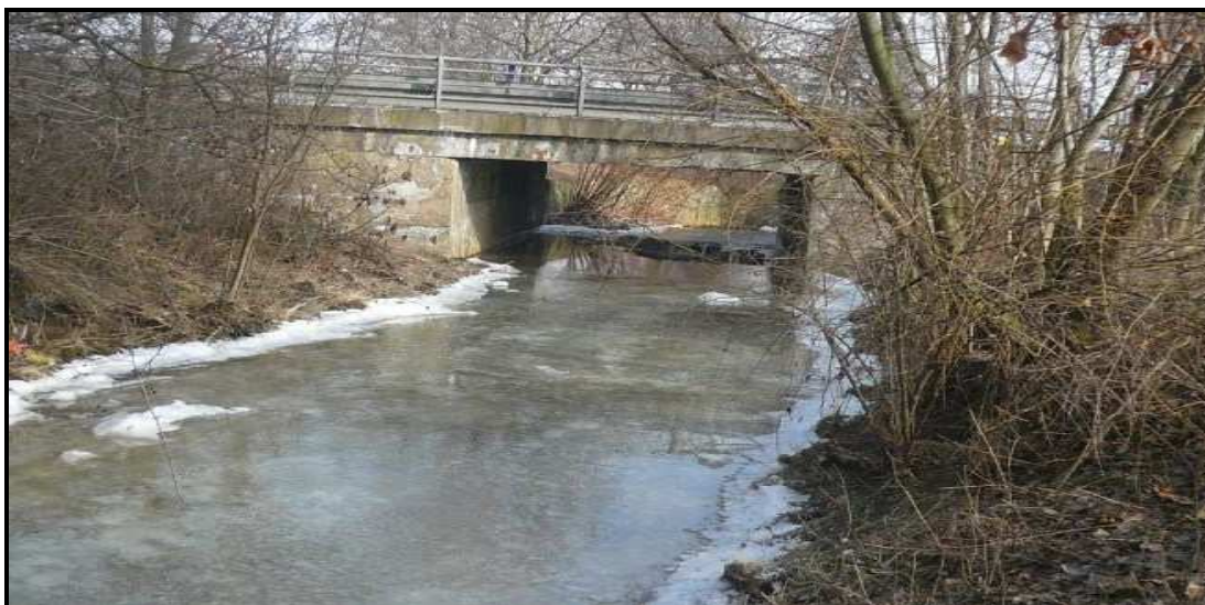
(Obr. 14.6. Pohled po směru toku na silniční most na R7 Praha – Chomutov, autor Petr Bujdák).
