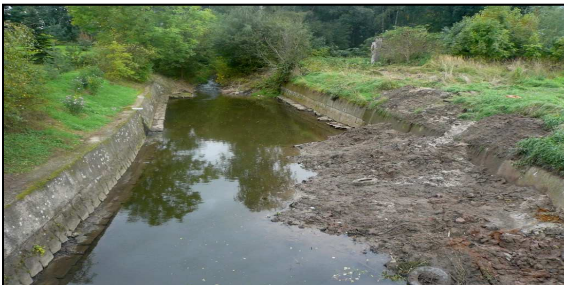
(Obr. 7.3. Tvrdě opevněné koryto v Hořenci, přechod do lesního porostu intravilán obce Hořenec ř. km 0,270 - Petr Bujdák, 09/2010).
