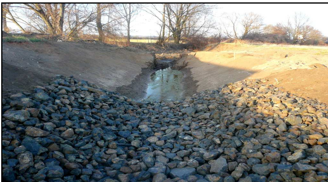
(Obr. 7.11. Odvodňovací příkop budoucí nové R7 v ř. km 1,721 - Petr Bujdák, 03/2011).
