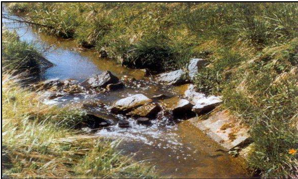
(Obr. 8.20. Pohled na profilovaný kamenný pás, zdroj (Netstorage, 2011)).
