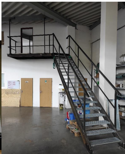
Obr. (19) Dokončení výstavby schodišť 112
