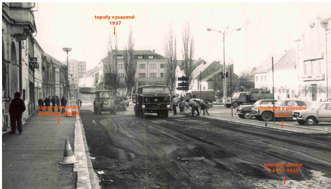
Obrázek 1: Pokládka asfaltu na náměstí v Březnici roku 1974
