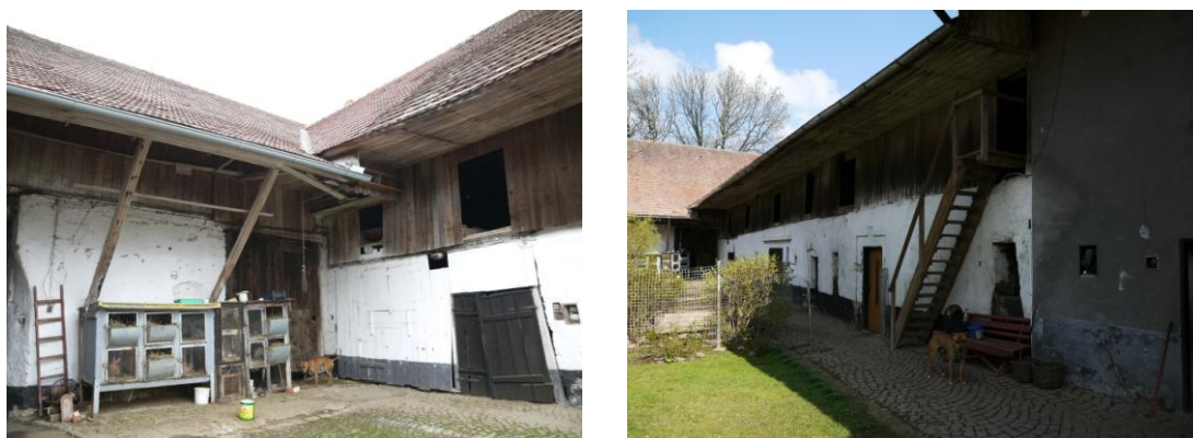
Obrázek 15: Stávající hospodářské objekty
