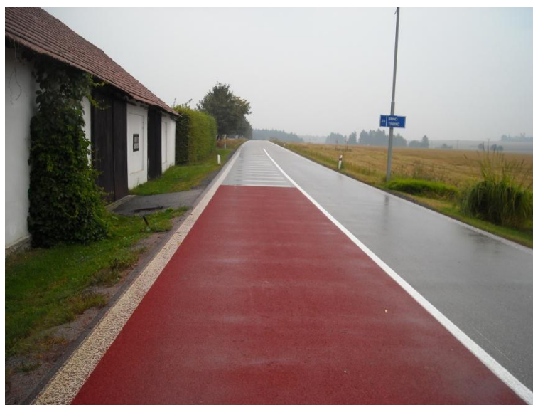
Obrázek č. 14- Povrch Rocbinda na vedlejší pozemní komunikaci
