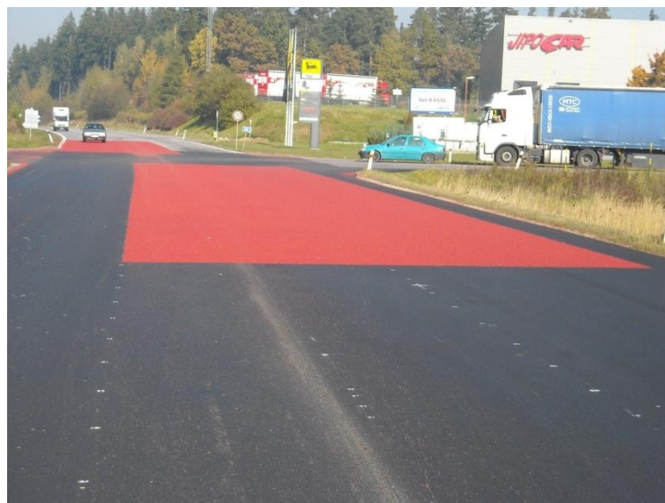
Obrázek č. 7 – Prvotní úprava povrchu na komunikaci I/38.
