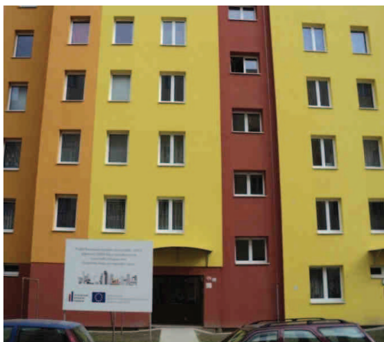
Obrázek č. 4 – Bytový dům V. Volfa 21 po revitalizaci
