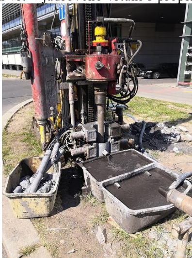
Obrázek 2 - hydrogeologických vrt – jádrového vrtání s proplachem
