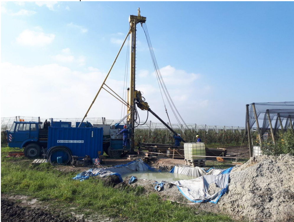
Příloha 1 - Vrtná souprava Wirth B-3
