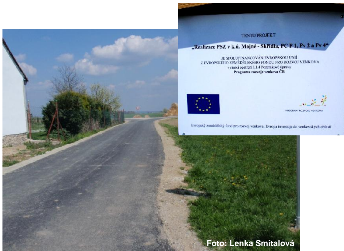
Foto 1: Rekonstrukce polní cesty v rámci realizace PSZ
