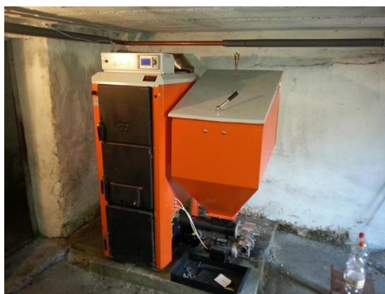
Obrázek 21 Automatický kotel na tuhá paliva se zásobníkem na pelety [50]
