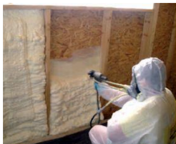
Obrázek 8 Zateplení střechy PUR pěnou [57]
