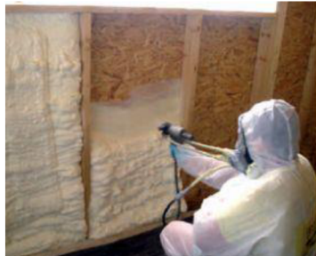
Obrázek 8 Zateplení střechy PUR pěnou [57]
