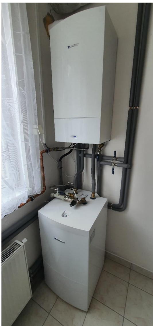
Obr. 7 Kondenzační kotel firmy Junkers se zásobníkem teplé vody [Archiv autora]
