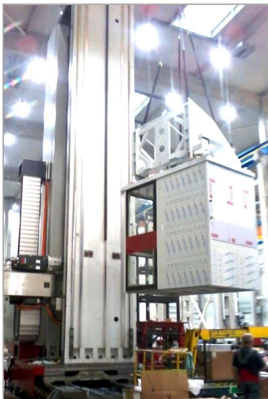
Montáž plošiny na stojan stroje
