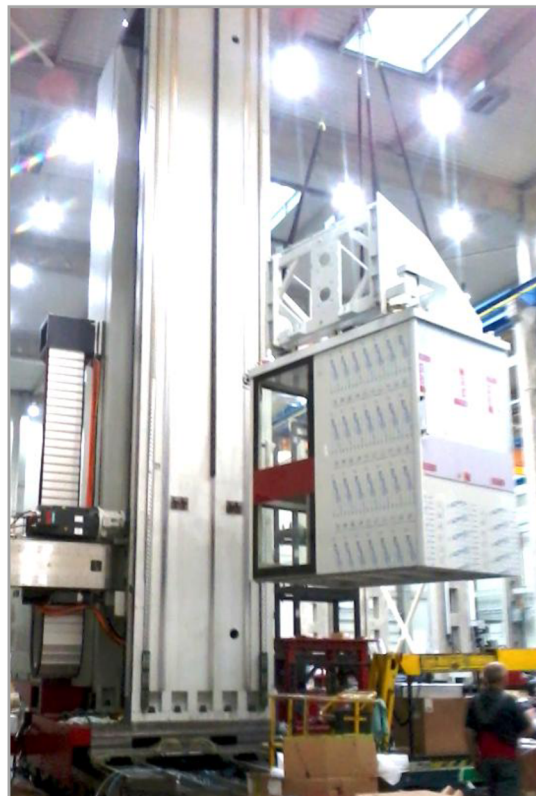
Montáž plošiny na stojan stroje
