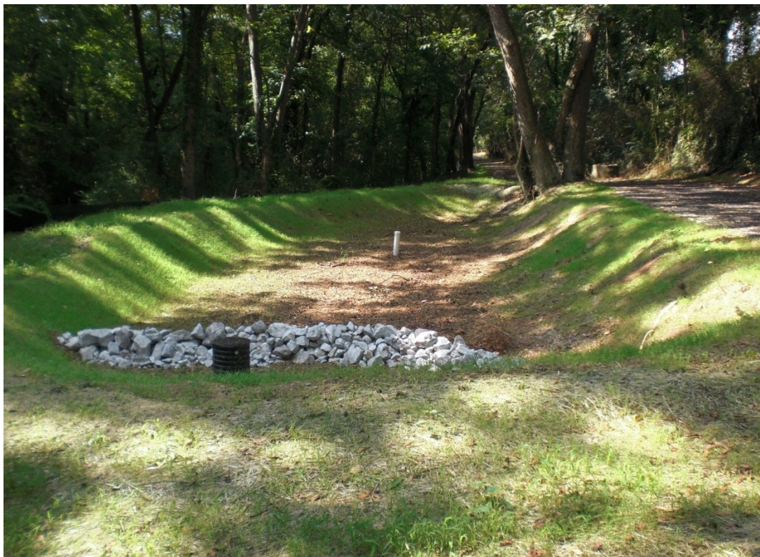
Obr. 3.20. Suchá retenční dešťová nádrž (poldr) [27]
