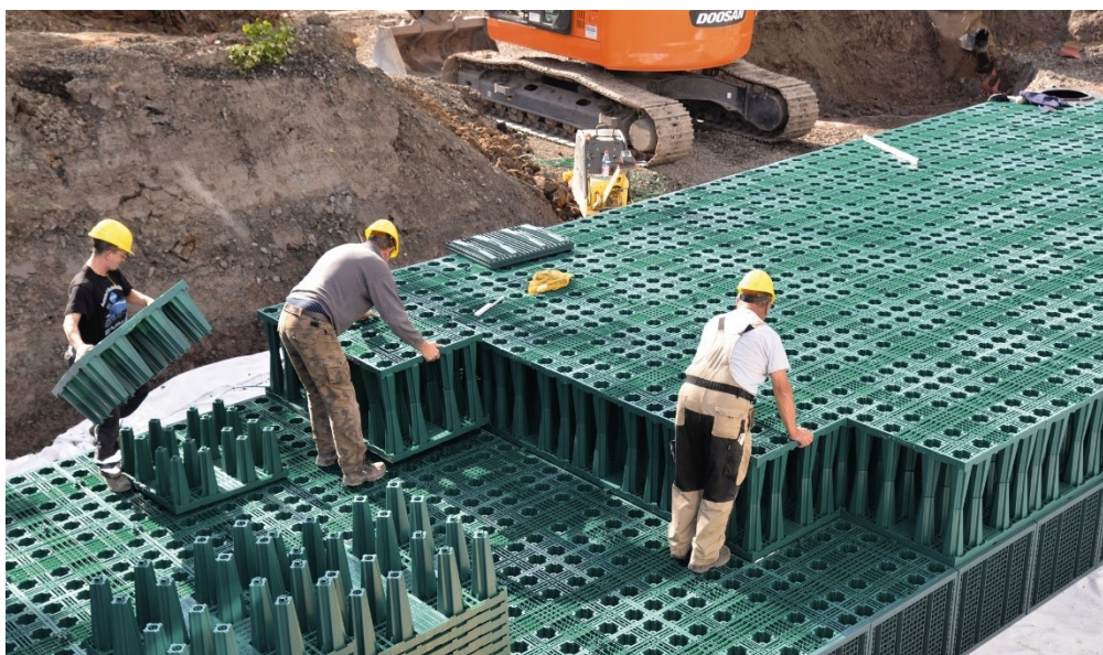
Obr. 3.16. Skládání vsakovacího bloku AS-RIGOFILL v praxi [25]
