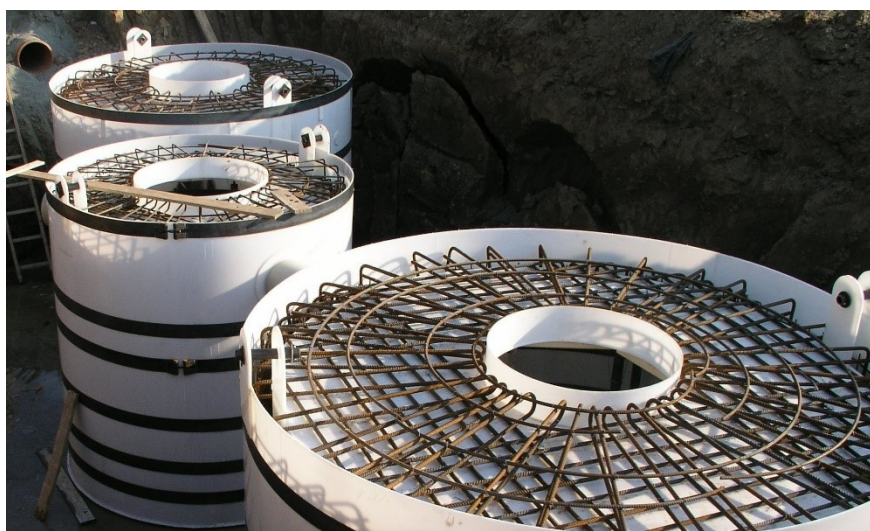
Obr. 3.8. Odlučovač lehkých kapalin AS-TOP [21]
