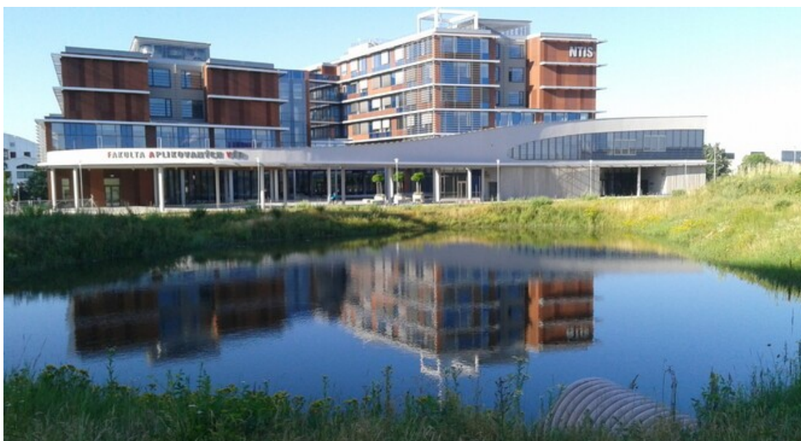
Obr. 3.22. Retenční dešťová nádrž se zásobním prostorem v Plzni [28]
