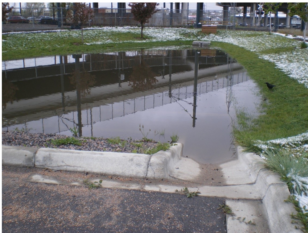
Obr. 3.12. Vsakovací průleh [55]
