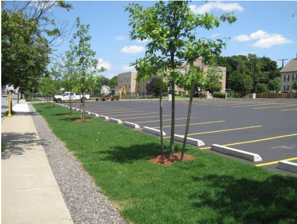
Obr. 3.14. Vsakovací rýha s plošným přítokem [8]
