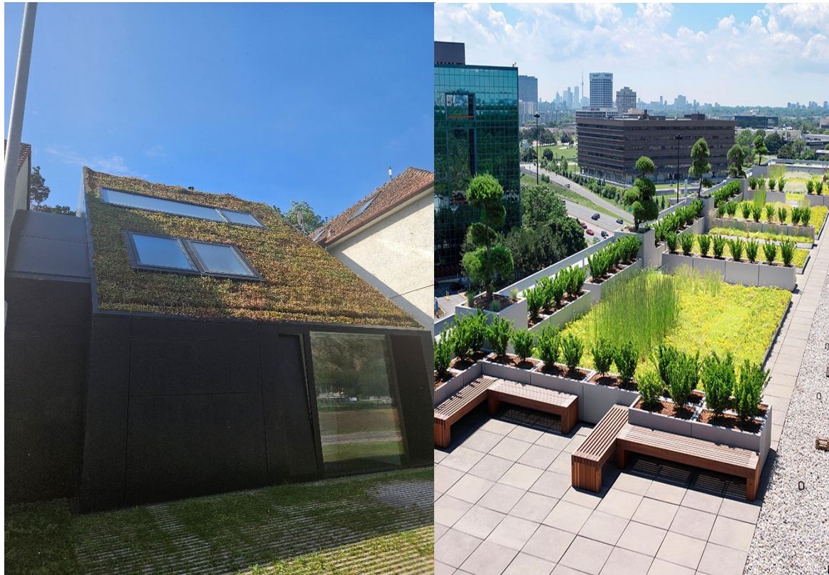
Obr. 3.25. Extenzivní střecha [vlastní]
