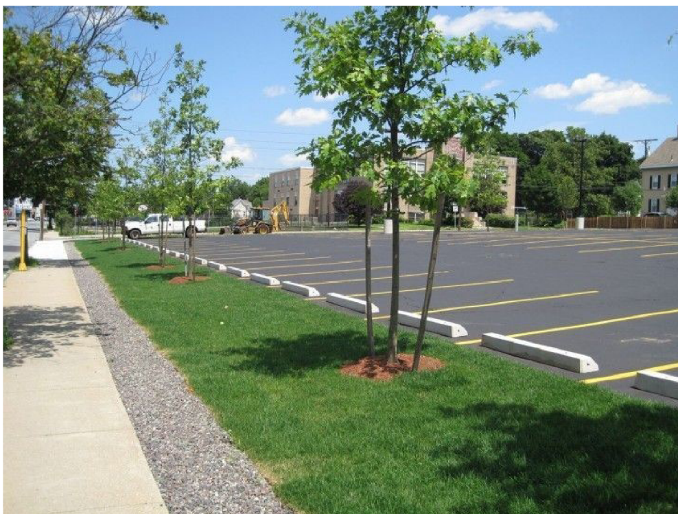
Obr. 3.14. Vsakovací rýha s plošným přítokem [8]
