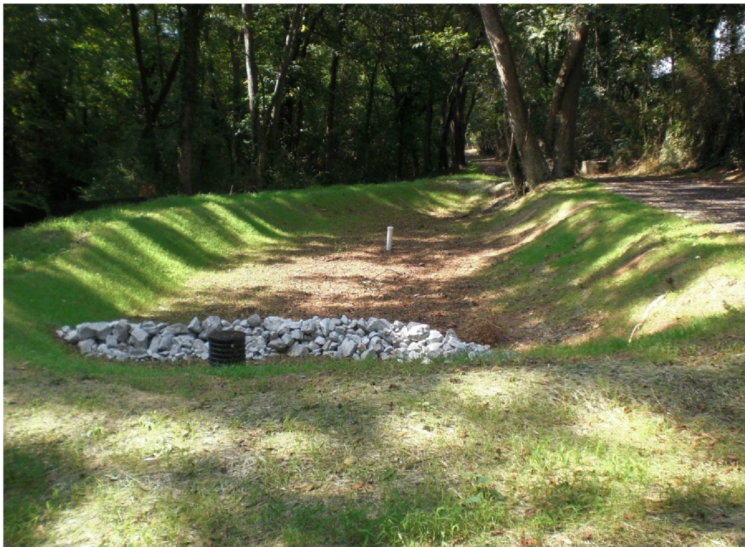
Obr. 3.20. Suchá retenční dešťová nádrž (poldr) [27]
