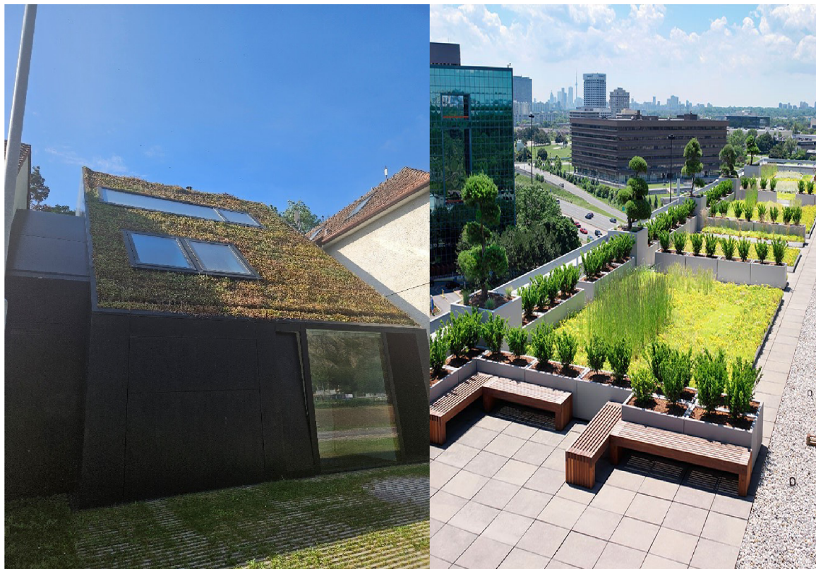
Obr. 3.25. Extenzivní střecha [vlastní]
