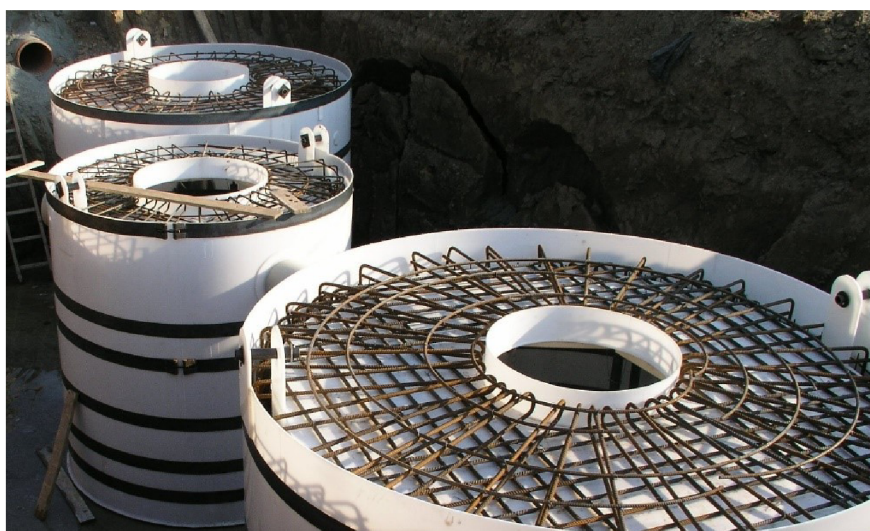
Obr. 3.8. Odlučovač lehkých kapalin AS-TOP [21]
