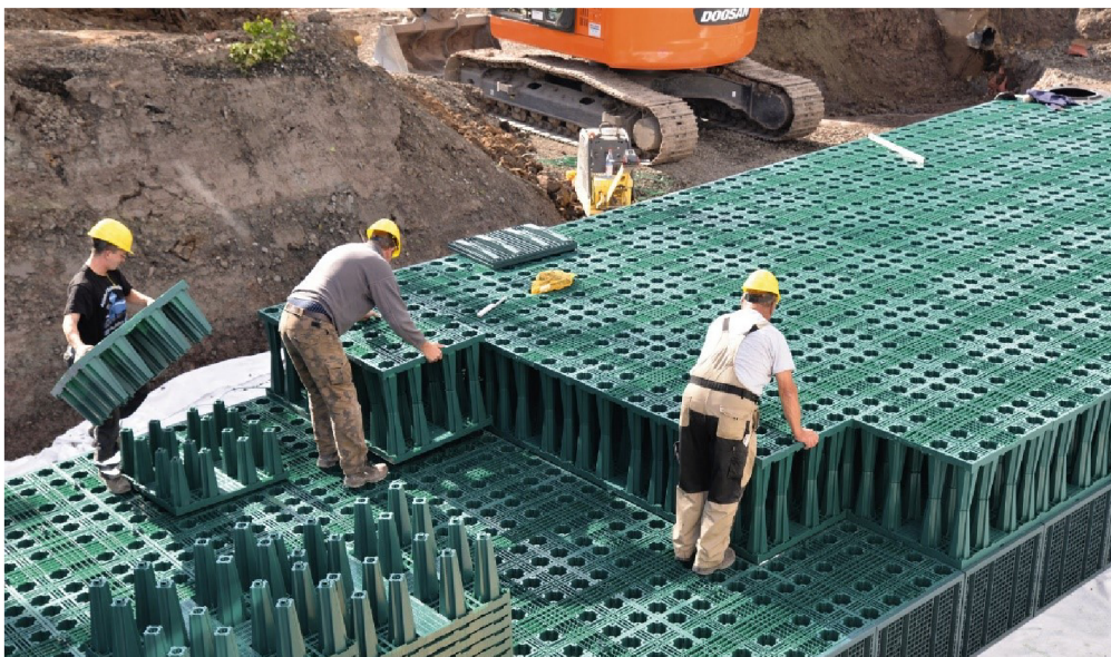
Obr. 3.16. Skládání vsakovacího bloku AS-RIGOFILL v praxi [25]
