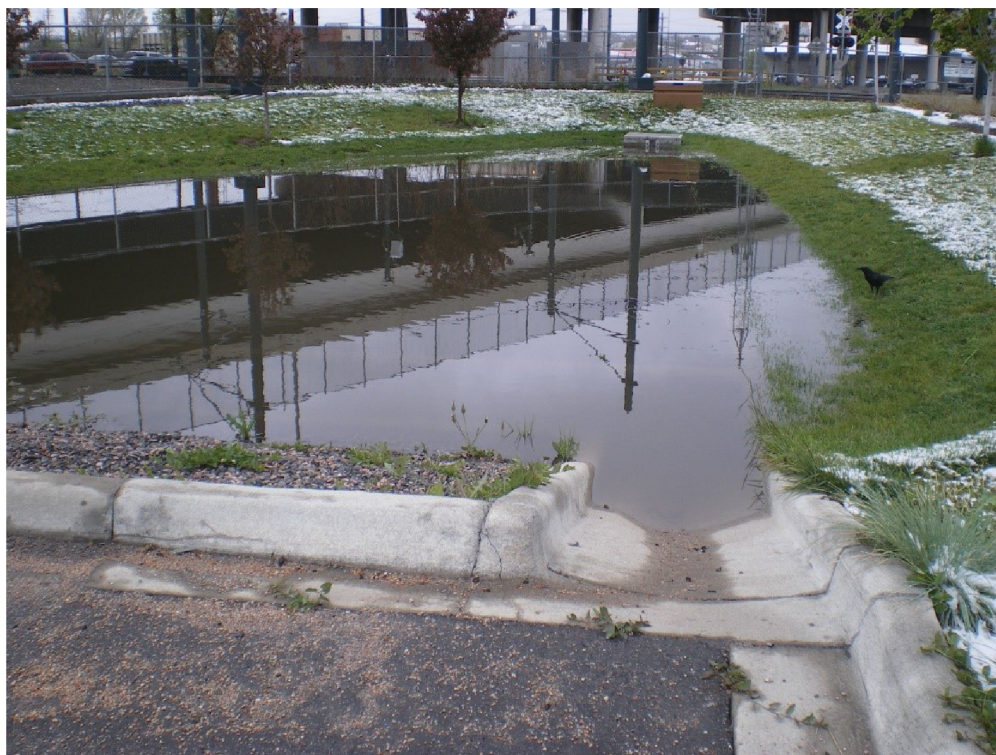
Obr. 3.12. Vsakovací průleh [55]
