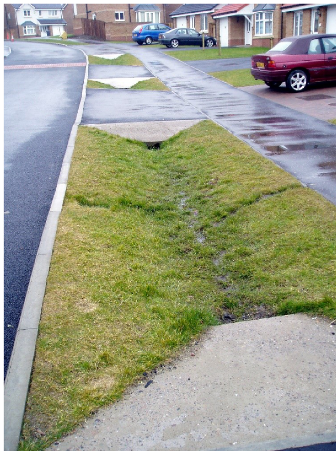
Obr. 3.12. Vsakovací průleh [55]
