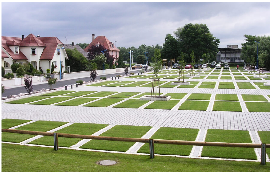
Obr. 3.10. Parkoviště s kombinací nezpevněné a zpevněné propustné plochy [24]
