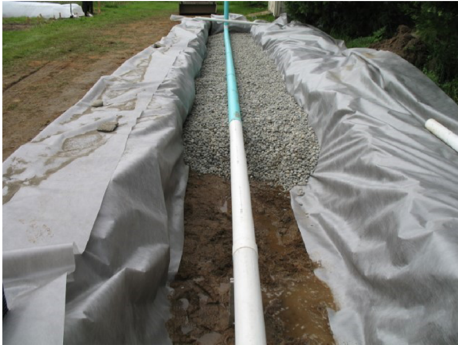
Obr. 3.15. Vsakovací rýha s podzemním přítokem v procesu výstavby [55]
