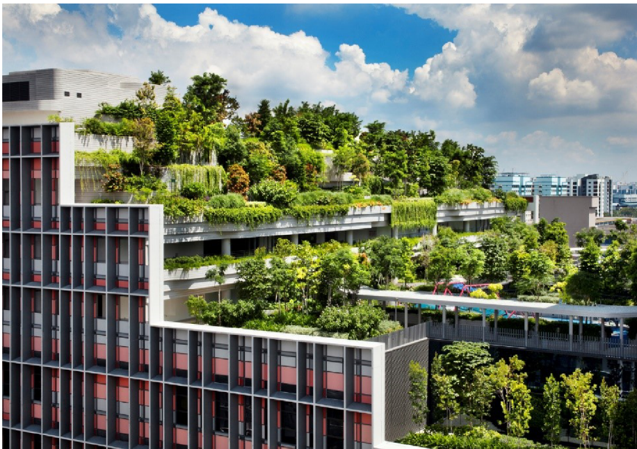
Obr. 3.5. Příklad zelené střechy jedné z budov v Singapuru [16]
