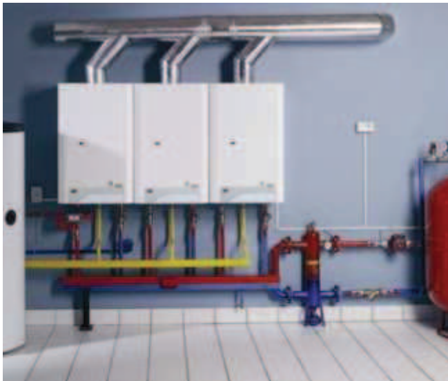
A.2.4.1 .Obr. 2 Kaskádová kotelna
