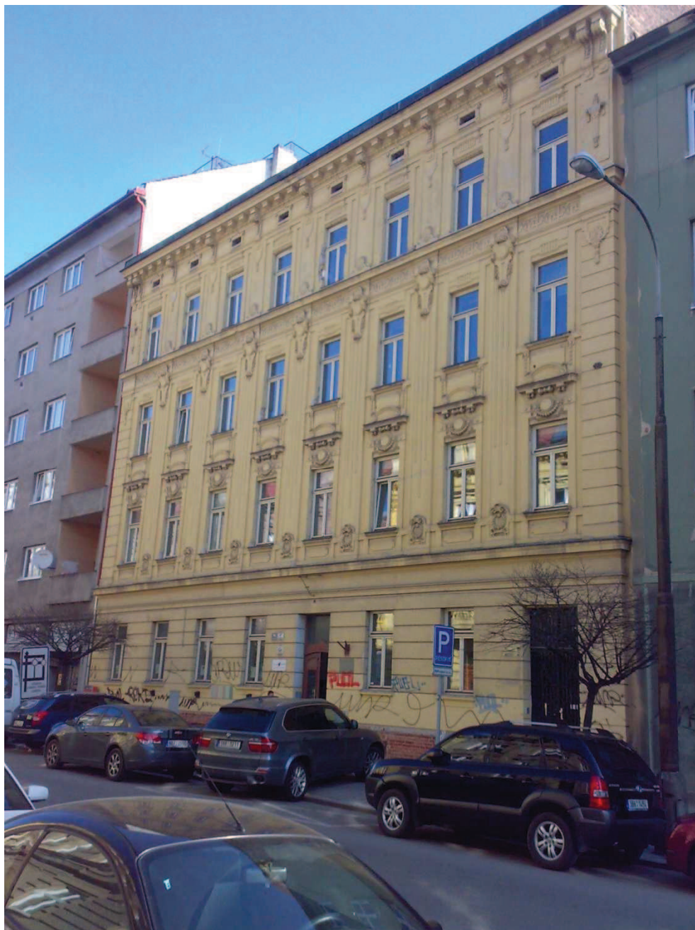
B.1. obr.1 počítaný objekt – západní historická stěna objektu
