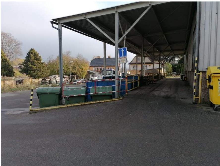
Obrázek 21: nájezdná rampa ke kontejnerům (vlastní, 2020).
