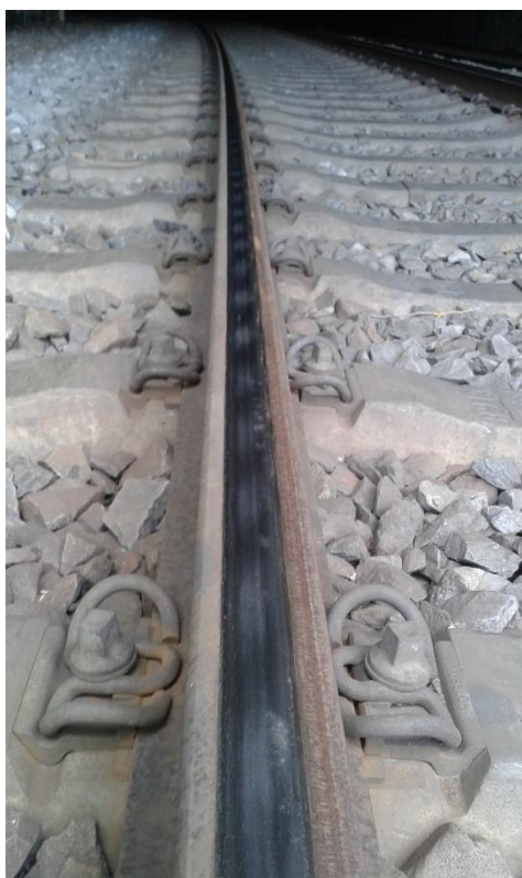
Obr. 24 Pohled do tunelu č. 2
