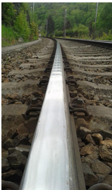
Obr. 19 Skluzové vlny
