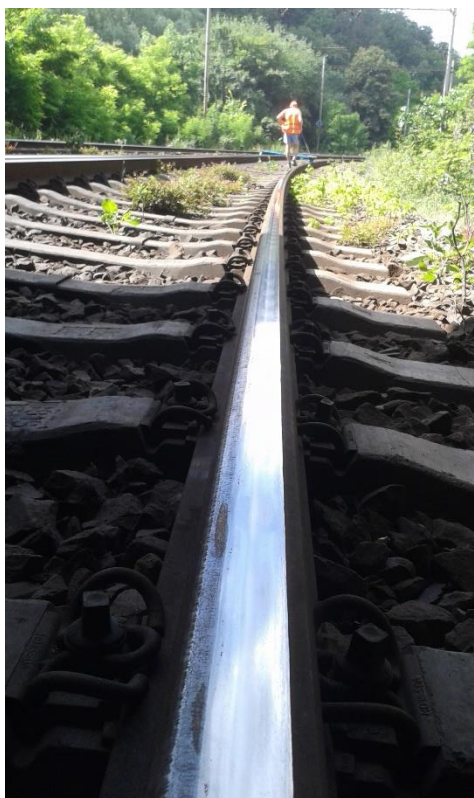
Obr. 25 Pohled z tunelu č. 2
