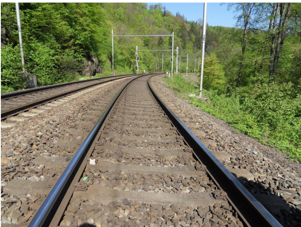
Obr. 10 Pohled na měřící místo BV1.1 z druhé koleje
