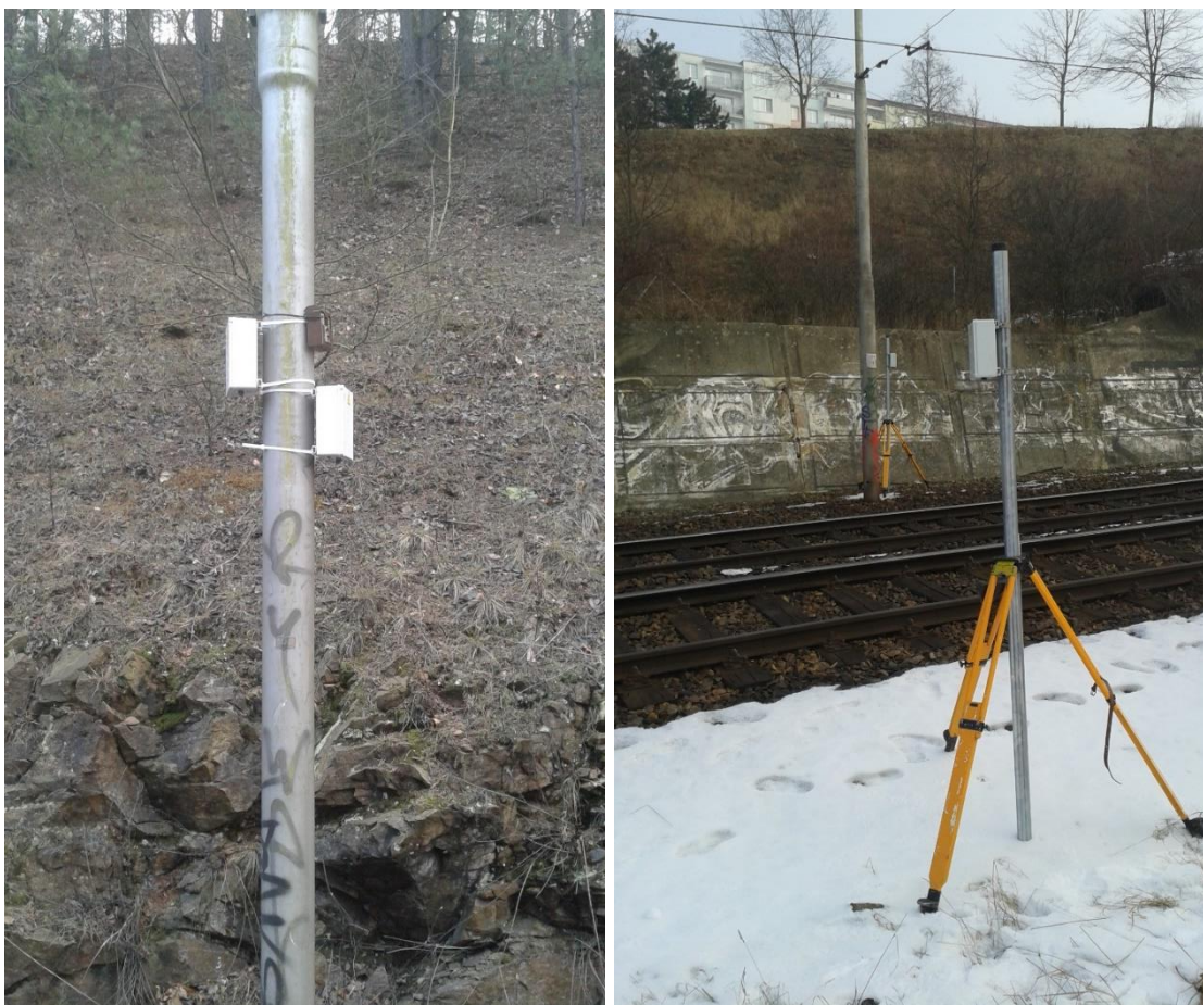
Obr. 60 Vlevo zařízení DRS (Mrkev) a optické záznamové zařízení na stožáru trakčního vedení, vpravo ve stativu
