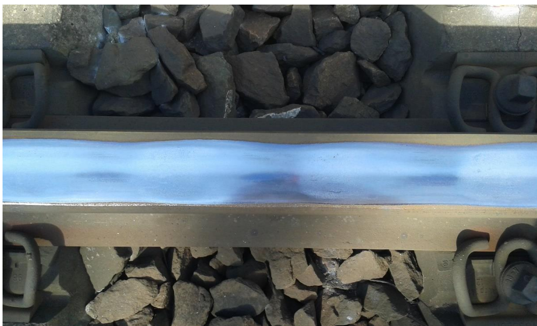
Obr. 6 Skluzové vlny na místě BS1.2 dne 5. 6. 2016 před výměnou kolejnic
