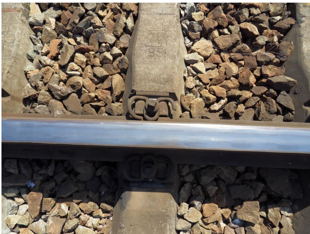
Obr. 4 Ulomená svěrka upevnění
