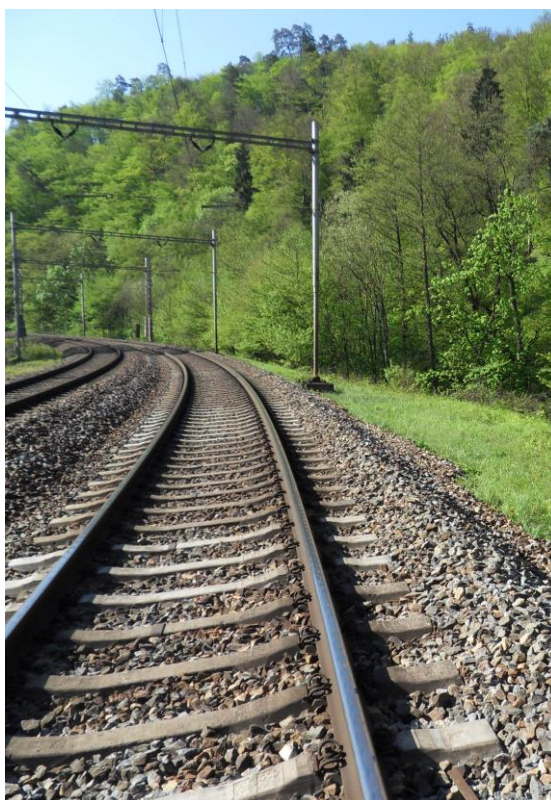
Obr. 12 Střídání nových a starých pražců
