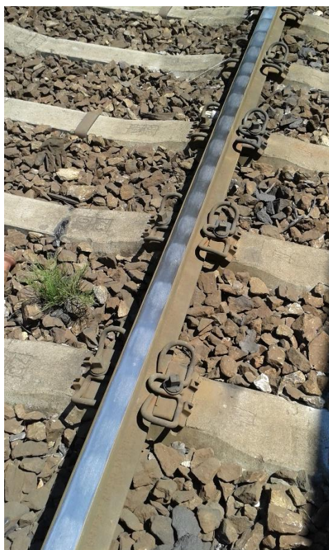
Obr. 33 Pohled na vnitřní kolejnici
