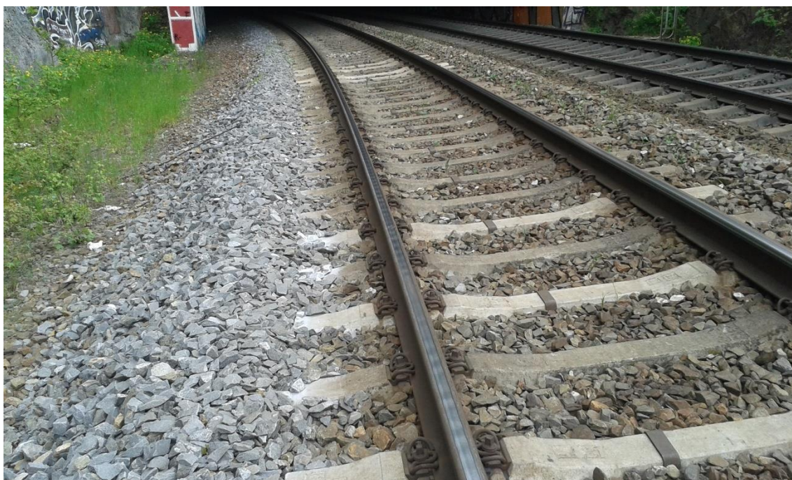
Obr. 21 Skluzové vlny a vyměněné pražce
