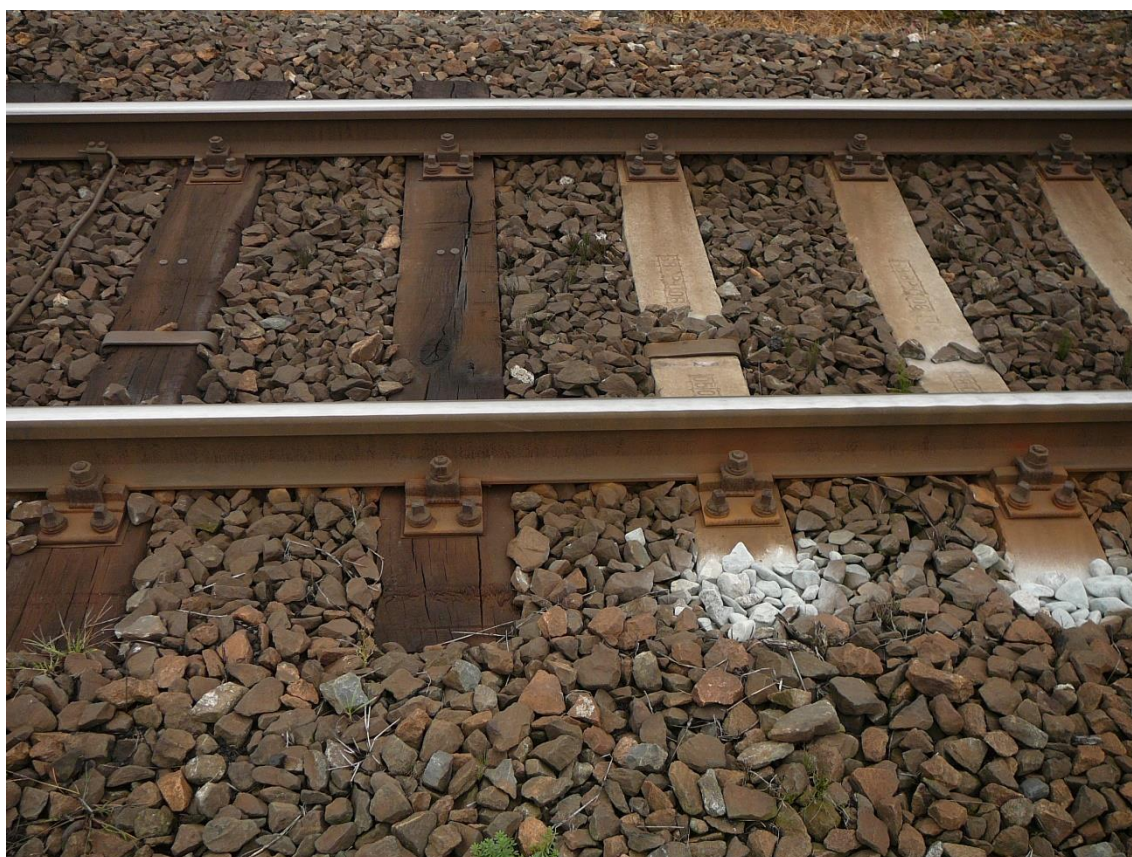
Obr. 40 Dřevěné a betonové pražce na úseku Velký Osek
