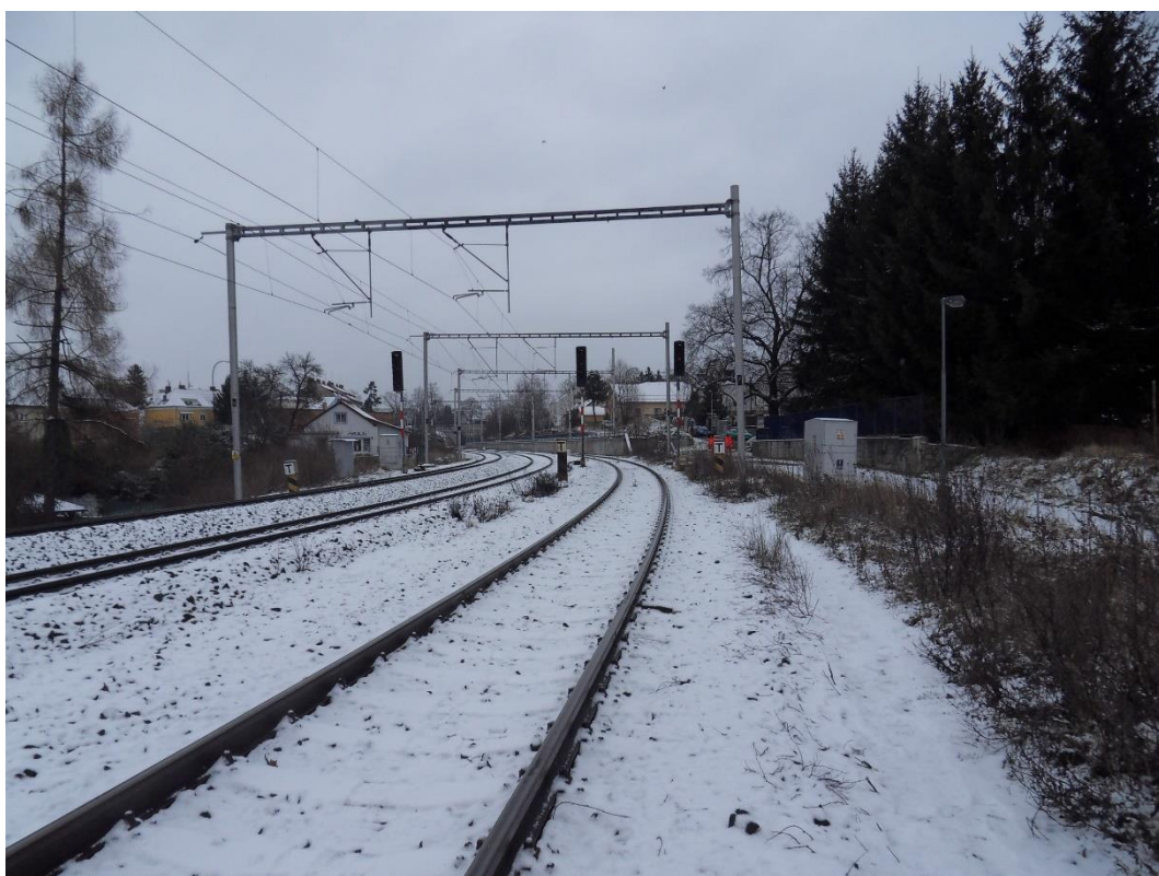
Obr. 37 Pohled k měřicím místům
