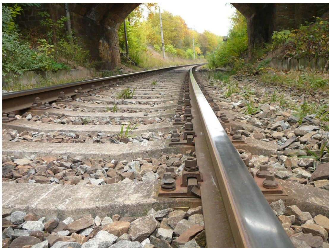
Obr. 43 Vnitřní kolejnice v oblouku na úseku Vyškov
