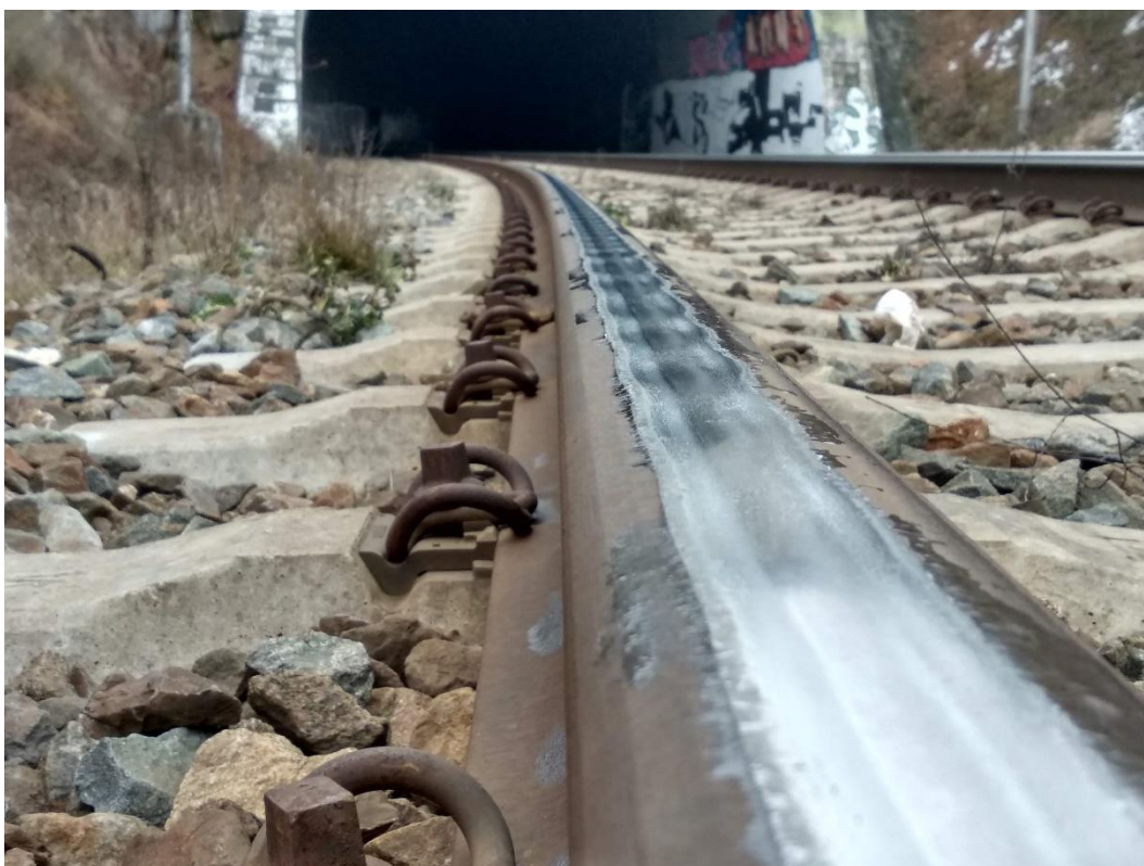
Obr. 16 Skluzové vlny zvýrazněné námrazou
