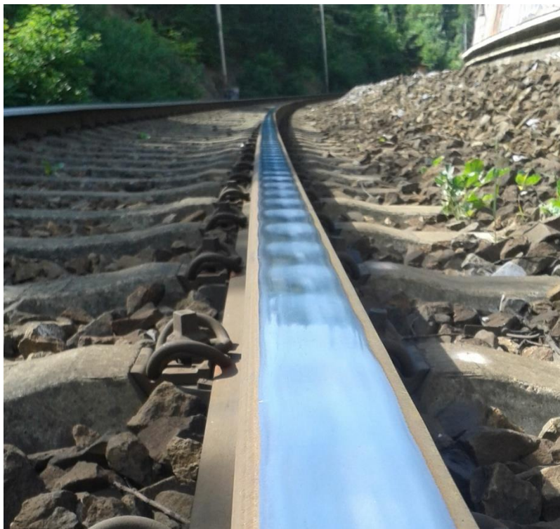
Obr. 1 Skluzové vlny v Babicích nad Svitavou
