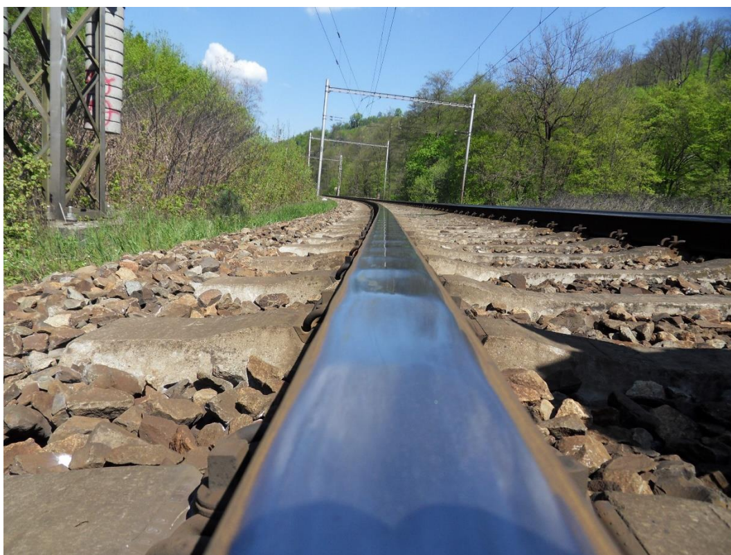
Obr. 7 Skluzové vlny na místě BS1.2 dne 5. 6. 2016 před výměnou kolejnic
