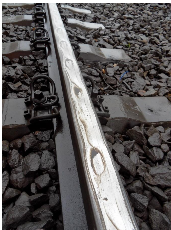
Obr. 34 Detailní pohled na vnitřní kolejnici
