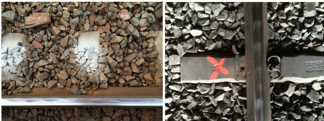
Obr. 5 Vlevo obroušené kamenivo, vpravo chybějící upevnění a ulomená svěrka, foto doc. Ing. Otto Plášek, Ph.D.
