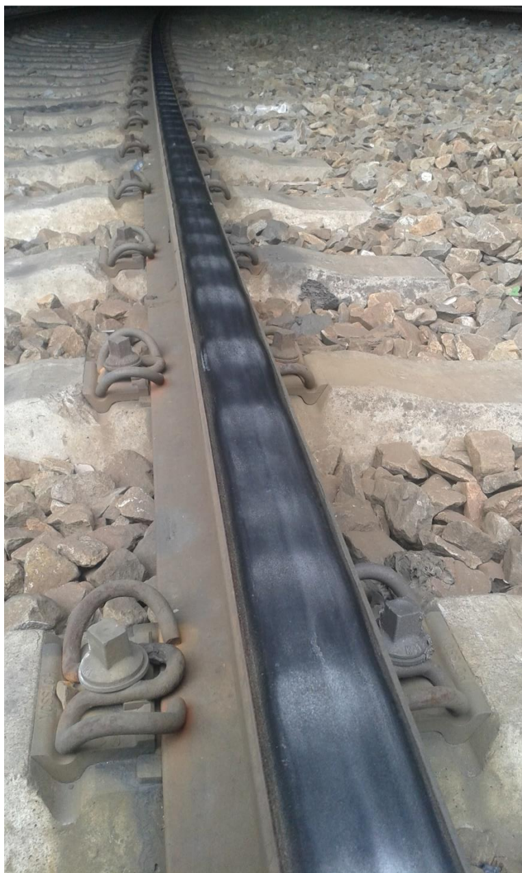
Obr. 3 Skluzové vlny na trati č. 326 Brno – Česká Třebová
