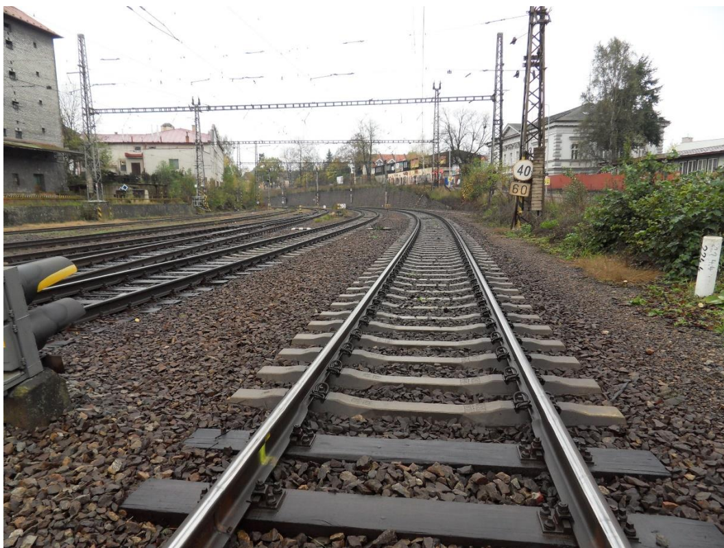
Obr. 27 Pohled od stanice směrem k měřicím místům
