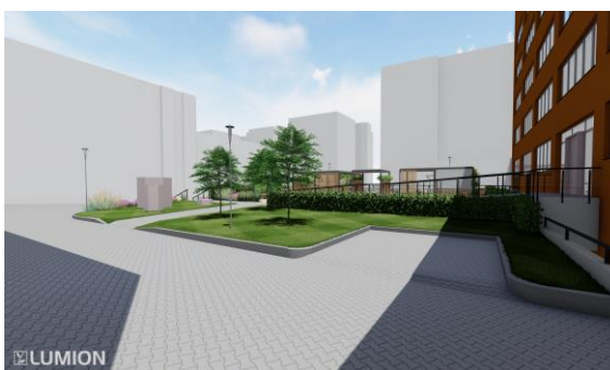
Obrázek 39: Pohled od vstupu do budovy E2
