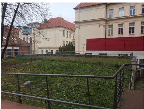
Obrázek 28: Pohled 1 od vstupu do budovy E1
