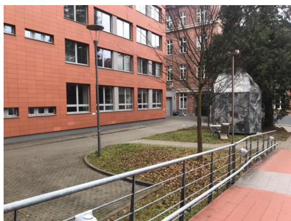
Obrázek 29: Pohled 2 od vstupu do budovy E1
