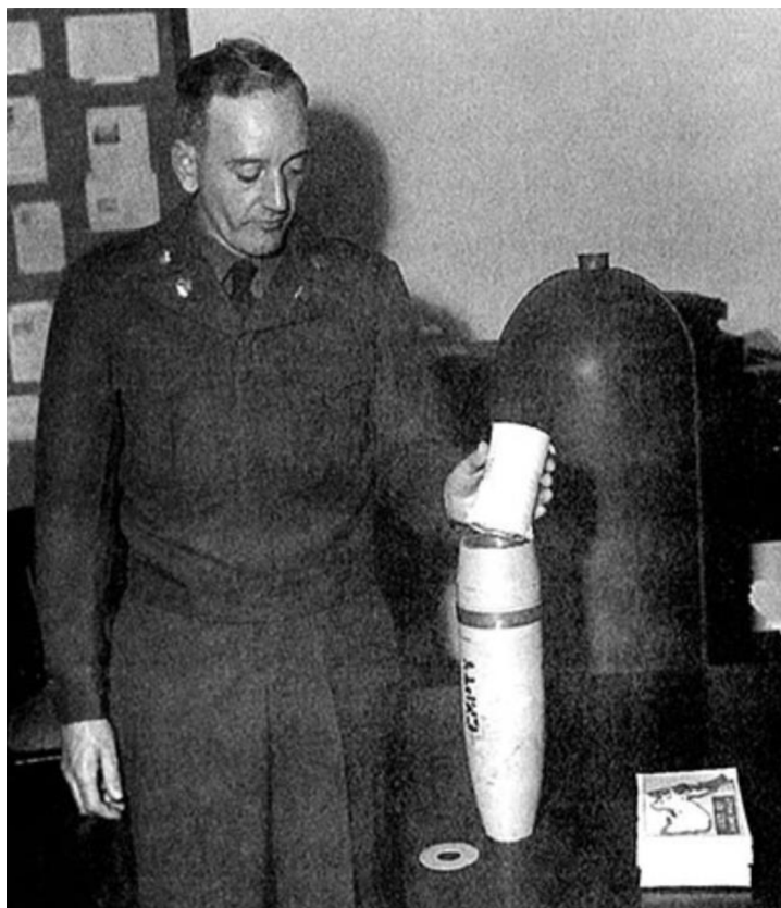
Obrázek 4: Rolka propagandistických letáků vkládána do dělostřeleckého projektilu
