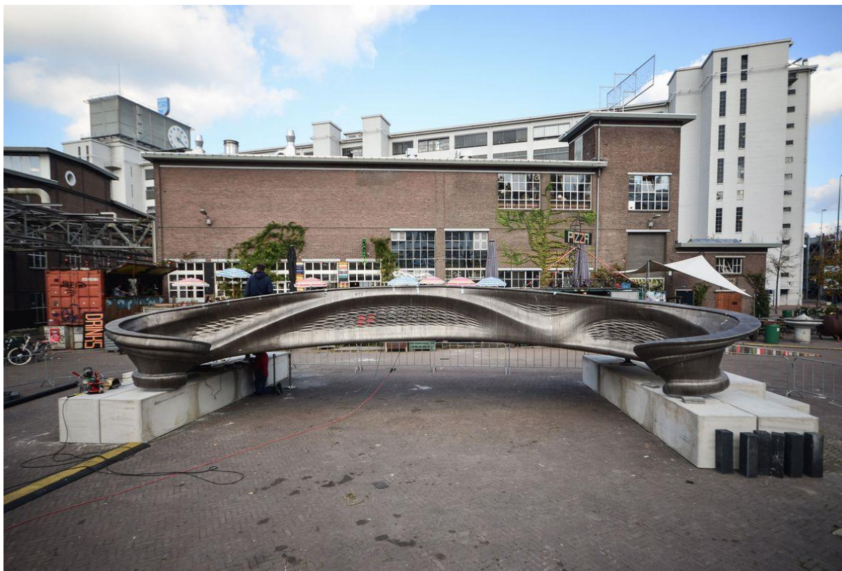
Obrázek 15 - Vytisknutý most nad kanál v Amsterdamu Zdroj: Stinson, c2019
