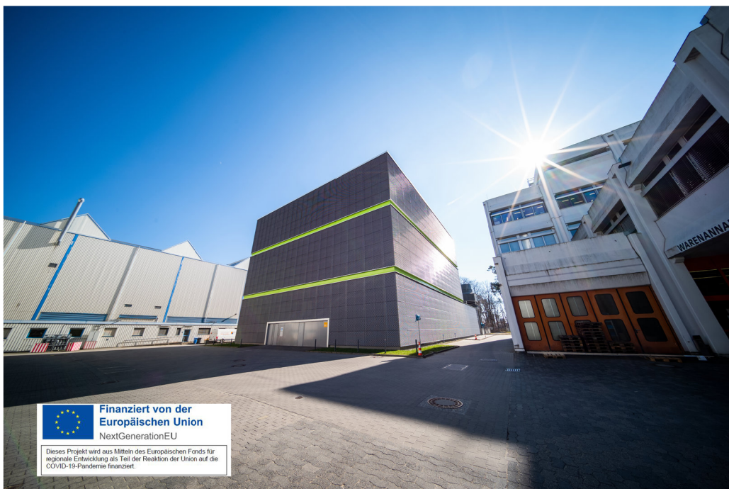
Obrázek 2.2: Fotografie datového centra Green IT Cube, Administrativní budova GSI je viditelná vpravo. Obrázek byl převzat z webových stránek GSI [17].
