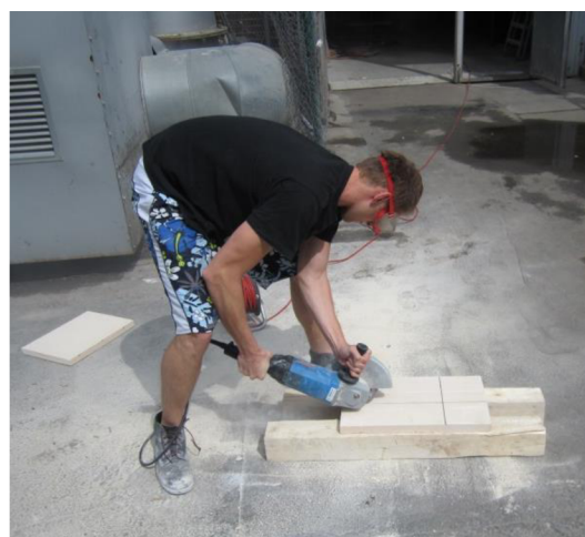
Obr. 52 Řezání samotové vyzdivky
