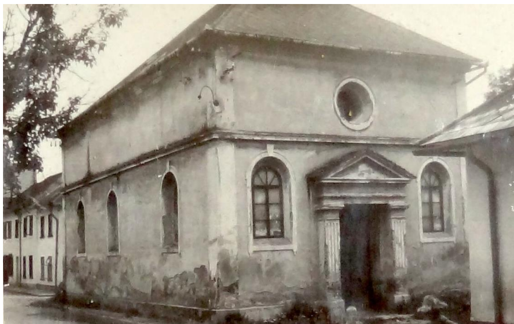
Obr. 16: Stav exteriéru, pohled od západu, r. 1930. 163
