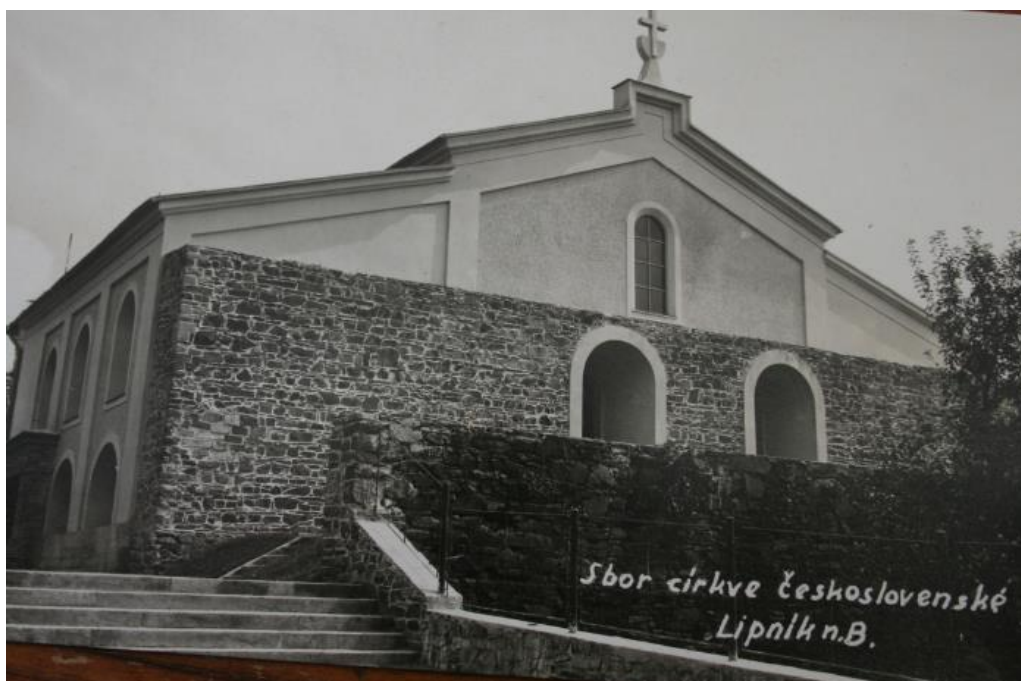
Obr. 5: Stav exteriéru po rekonstrukci 1950 – pohled od západu. 152
