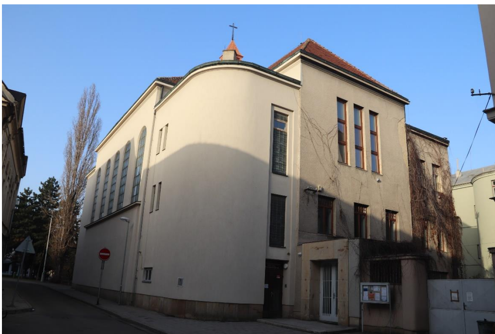
Obr. 39: Současný stav exteriéru, pohled od jihu. 186
