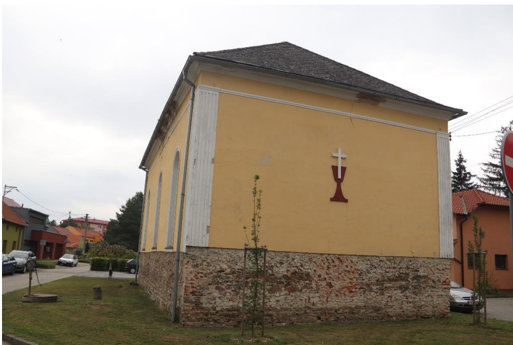
Obr. 23: Současný stav, pohled východní. 170
