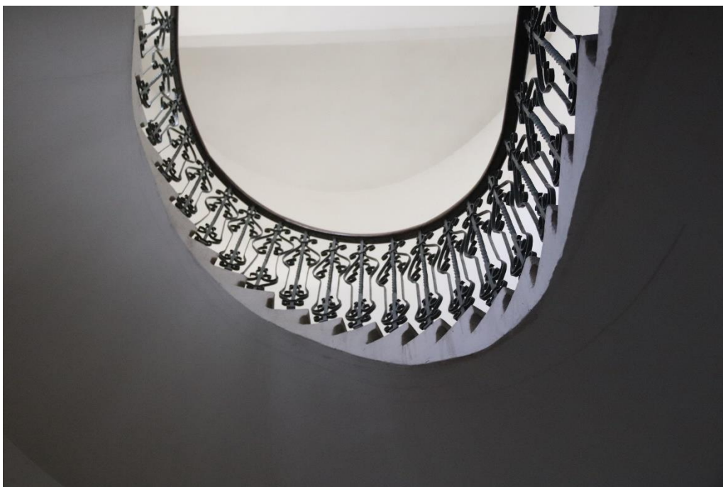
Obr. 48: Současný stav interiéru, pohled na schodiště s původním synagogálním zábradlím v jižní části budovy, která slouží jako zázemí sboru CČSH. 195
