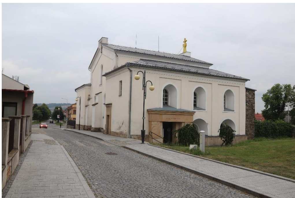
Obr. 11: Současný stav, pohled od severu. 158
