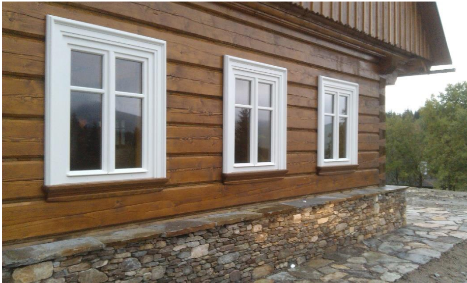
Obrázek 6 - Špaletová okna u roubené stavby
