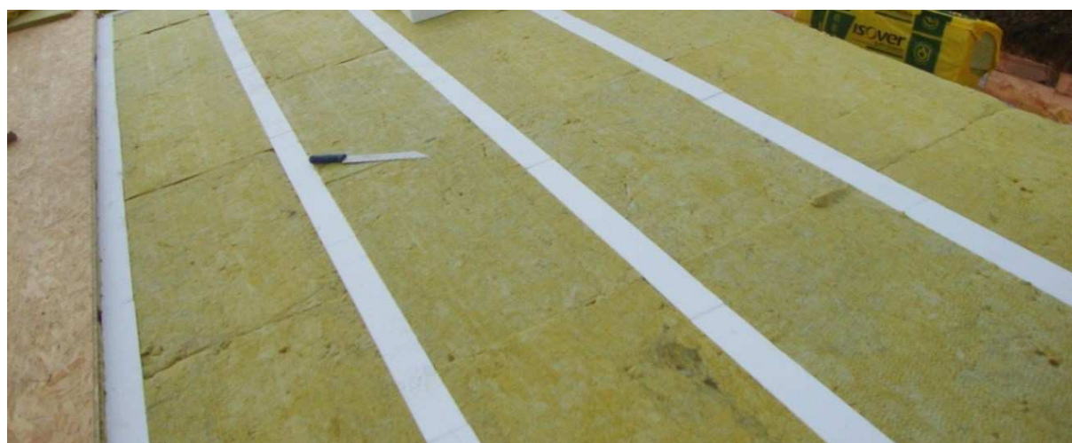
Obrázek č.22 - Provedení izolace střechy
