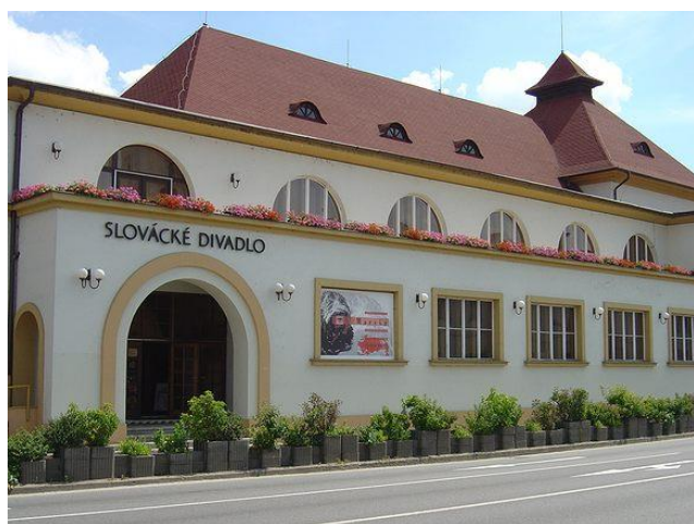
Obr. č. 25: Slováké divadlo v Uherském hradišti
