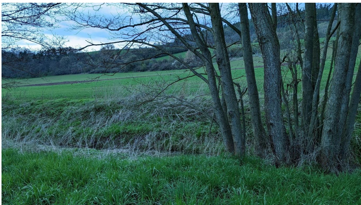
Obrázek č.27: Současný stav regulovaného koryta Černockého potoka za obcí Malá Černoc, směrem na Soběchleby. Koryto bylo v minulosti přesunuto, narovnáno a opevněno. Dnes velmi zabahněné. Neúplný břehový porost kolem vodoteče. (autor: Jan Lukáš, 2023)
