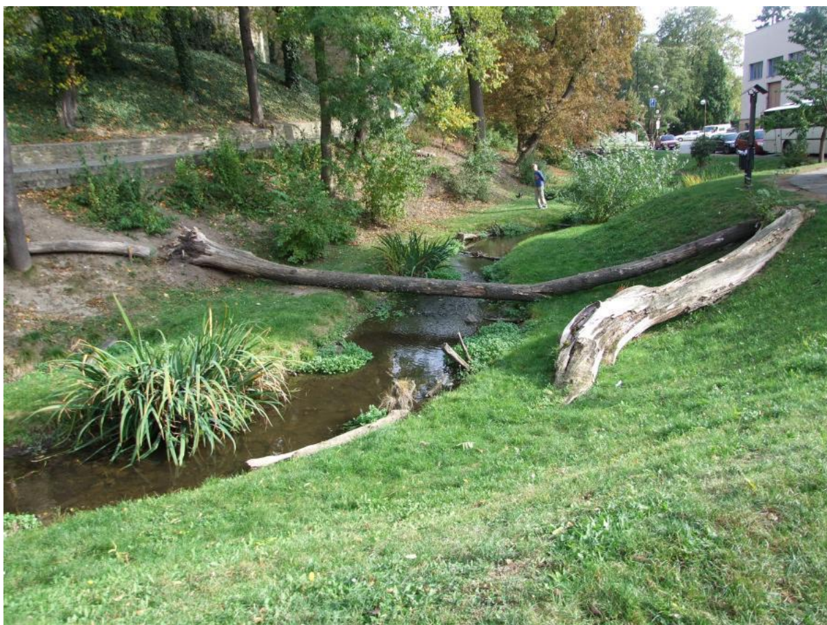
Obrázek č.12: Korytu mlýnského náhonu v centru města Chrudim přibylo po revitalizaci dřevo, brody, flóra a další prvky, které se běžně vyskytují v přirozených korytech. Příklad revitalizace v intravilánu obce. 78
