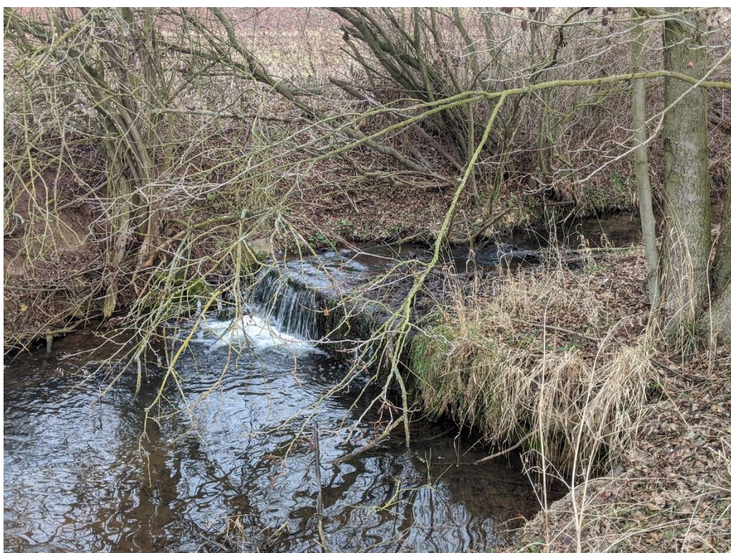
Obrázek č.28: Kamenný stupeň s velkým nánosem erozního materiálu v řešené části toku. (autor: Jan Lukáš, 2020)
