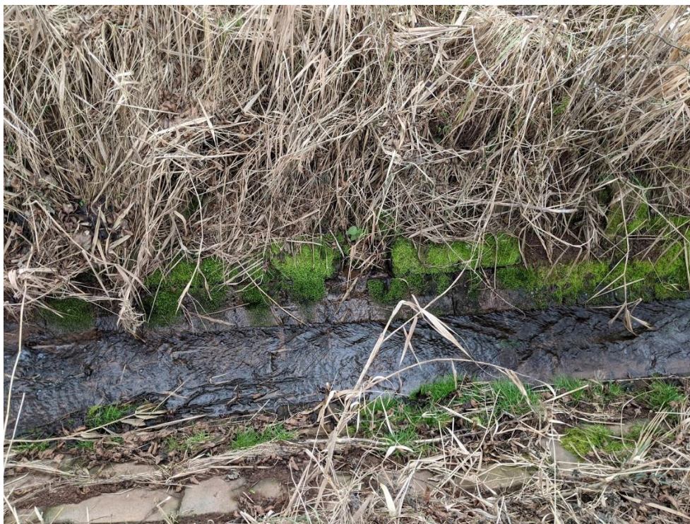
Obrázek č.31: Opevněné koryto Černockého potoka za obcí Svojetín. (autor: Jan Lukáš, 2020)
