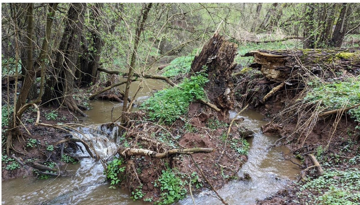
Obrázek č.35: Přirozený úsek Černockého potoka mezi úsekem „gumový potok“ a obcí Malá Černoc. Ve 20 m široké strži tok není opevněn. Jsou zde velmi časté potoční nátrže. (autor: Jan Lukáš, 2023)
