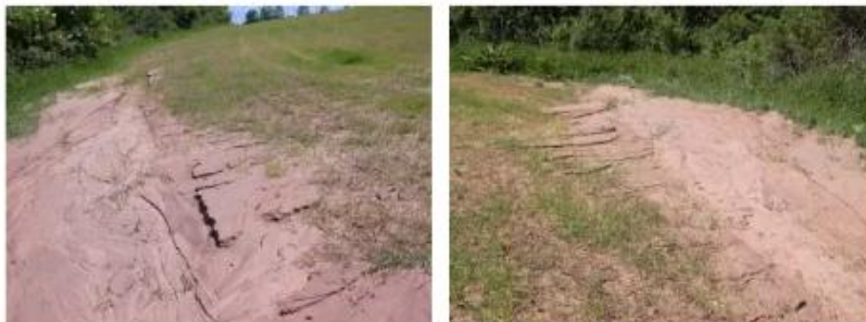
Obrázek č.19: Následky plošné eroze jižně od obce Soběchleby v povodí Černockého potoka. (autor: Jiří Kaldec, 2005)
