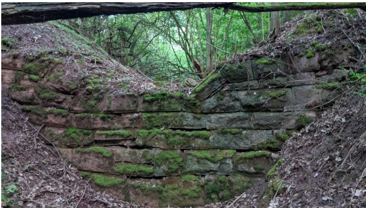
Obrázek č.15: Pohled na přehrážku, který je již zcela zazemněna v hluboké strži nad obcí Malá Černoc. (autor: Jan Lukáš, 2022)
