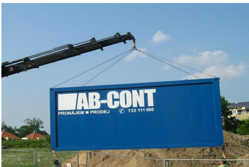
Obr. 7.19 Překládání kontejnerů lany [21]
