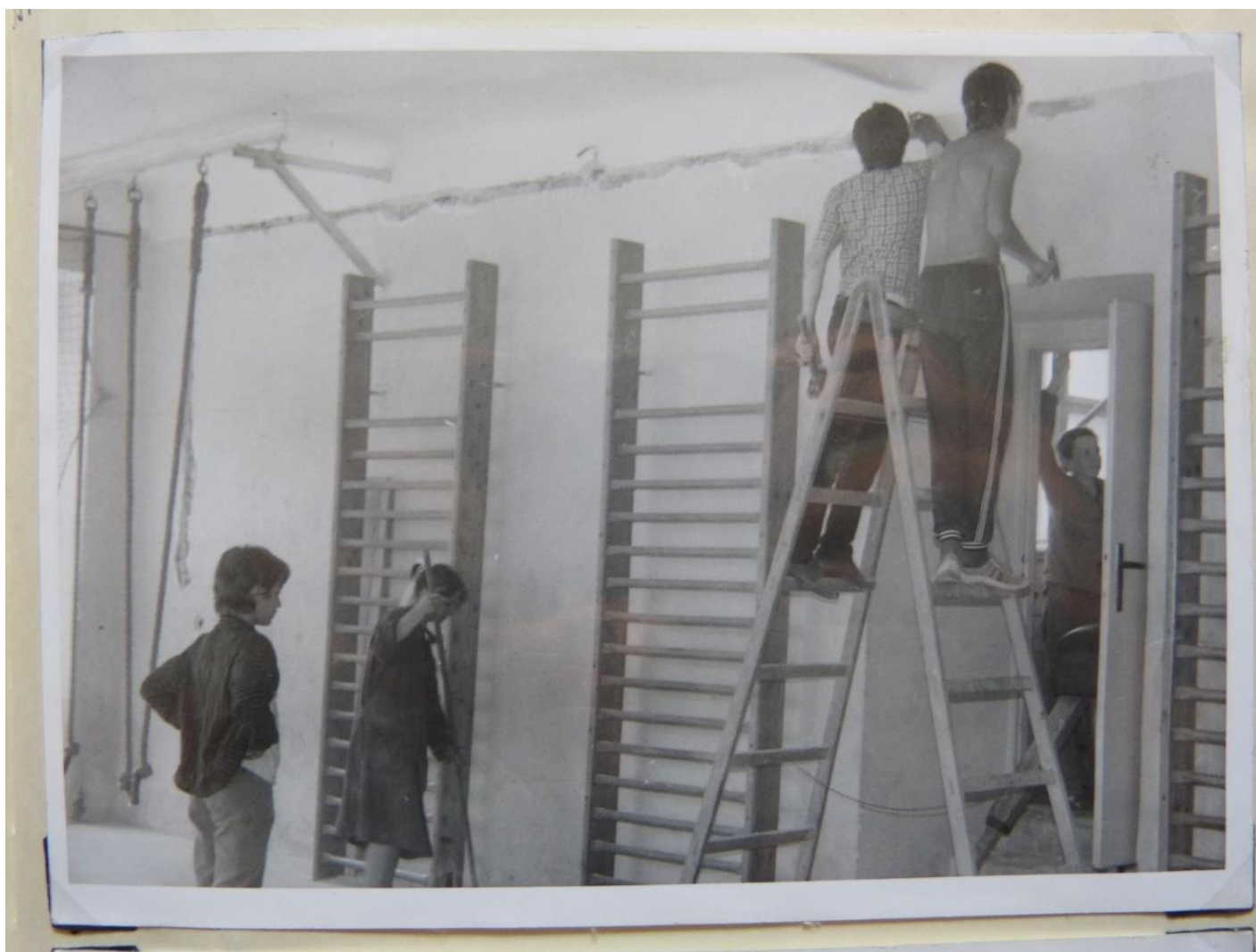
Generální oprava elektroinstalace na sušickém gymnáziu, rok 1987. Fotokopie kroniky školy.
