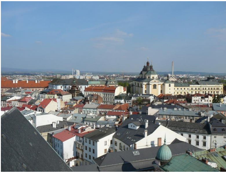
Obr. 4: Východní část městského centra z mořické věže
