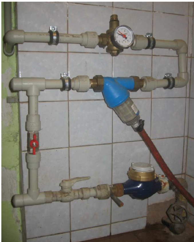
Obr. 4.14: Vodovodní přípojka po dokončení měření [17]
