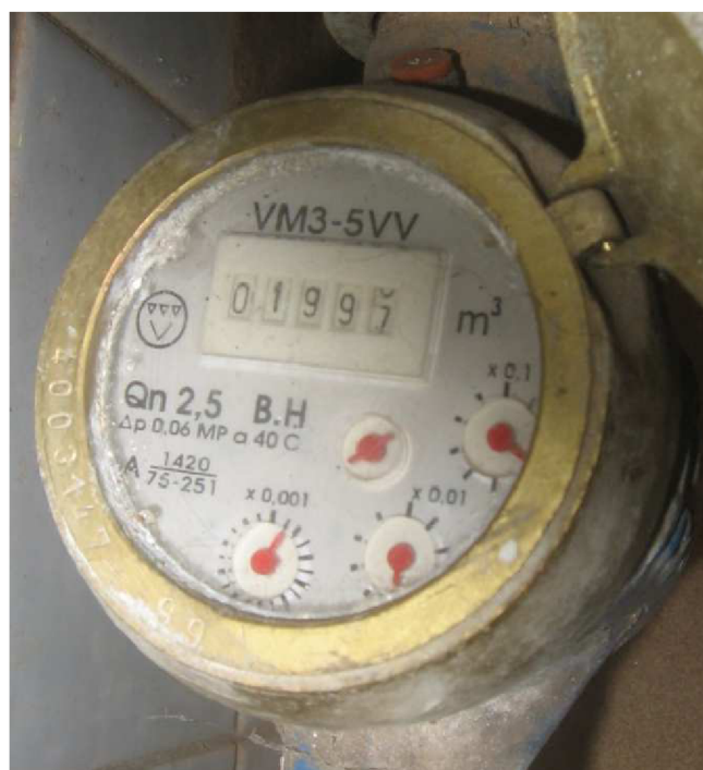
Obr. 4.8: Původní vodoměr [17]
