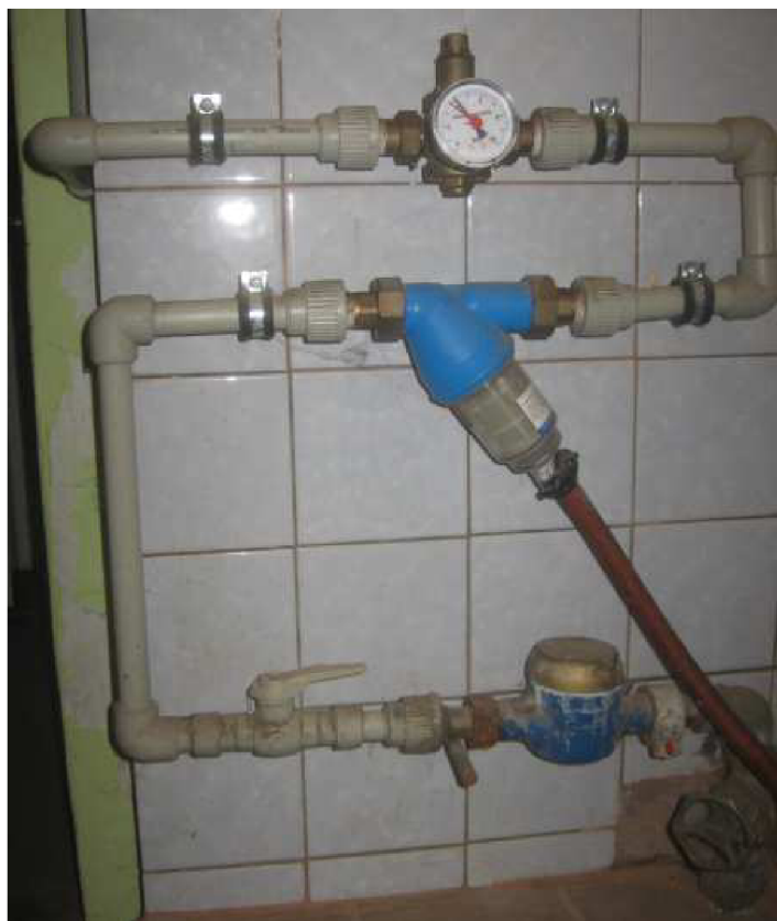
Obr. 4.1: Vodovodní přípojka bez UFR [17]
