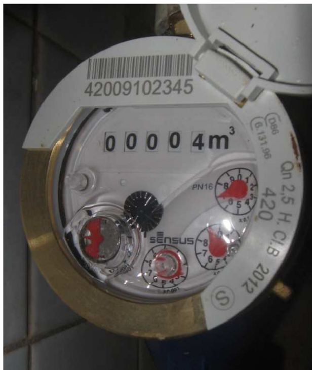
Obr. 4.9: Nový vodoměr [17]
