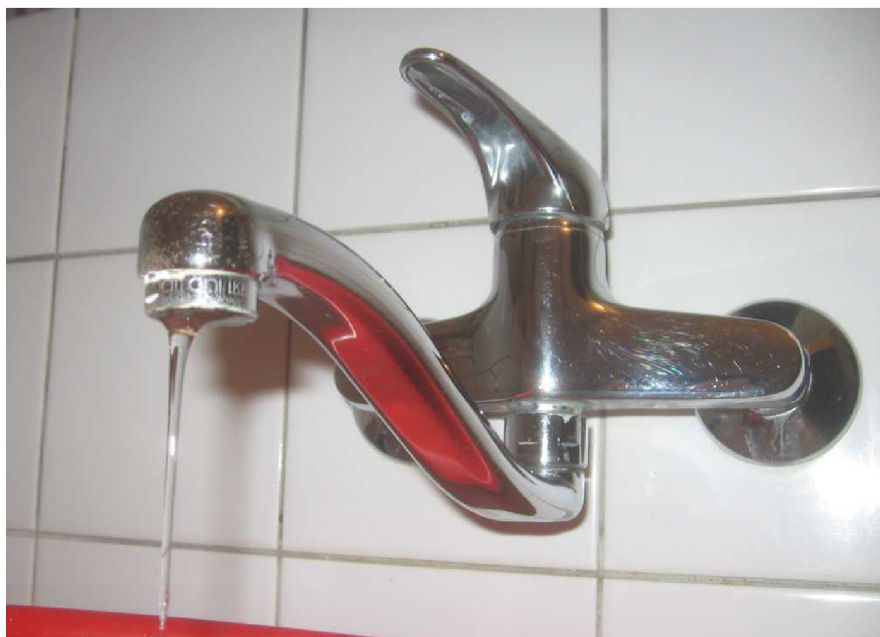
Obr. 4.12: Průtok 12 l/hod [17]
