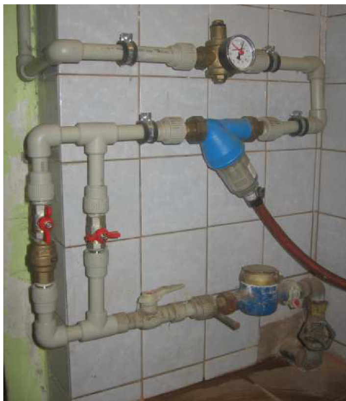
Obr. 4.2: Vodovodní přípojka s UFR [17]
