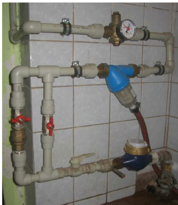
Obr. 4.10: Zapojení nového vodoměru [17]
