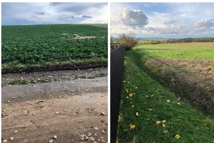
Obr. 65: Usazeniny půdních částic na VPC C-4; Obr. 66: Hrázka vybudovaná mimo PSZ
