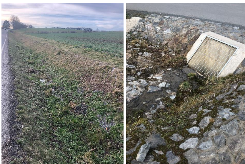
Obr. 13: O 13; Obr. 14: vyústění příkopu O 13
