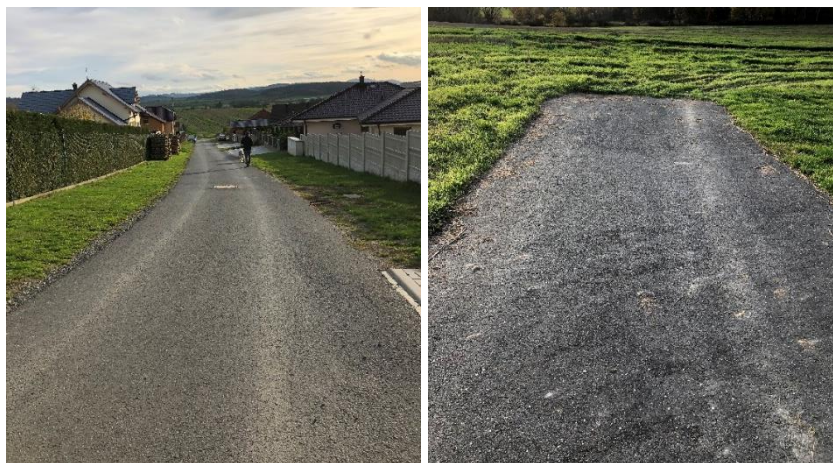
Obr. 19: VPC C-13 sloužící jako komunikace pro přilehlou zástavbu; Obr. 20: Ukončení VPC C-14
