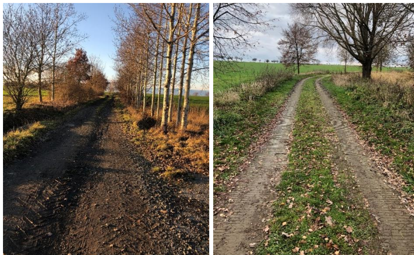
Obr. 26: VPC 5 s doprovodnou zelení a příkopem po levé straně; Obr. 27: Úsek VPC 7 z kolejových prefabrikátů
