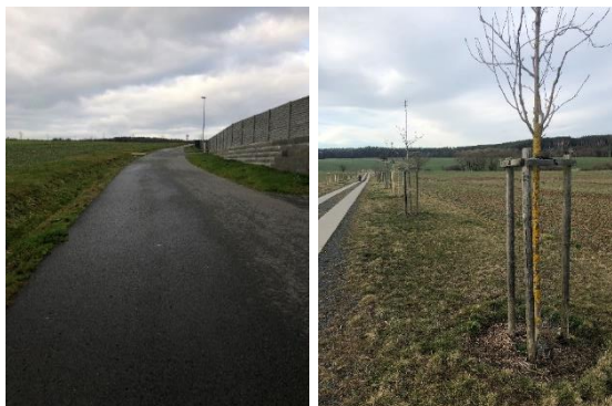
Obr. 7: HPC 1 – zpřístupnění obytné části s odvodněním; Obr. 8: doprovodná zeleň podél HPC 1
