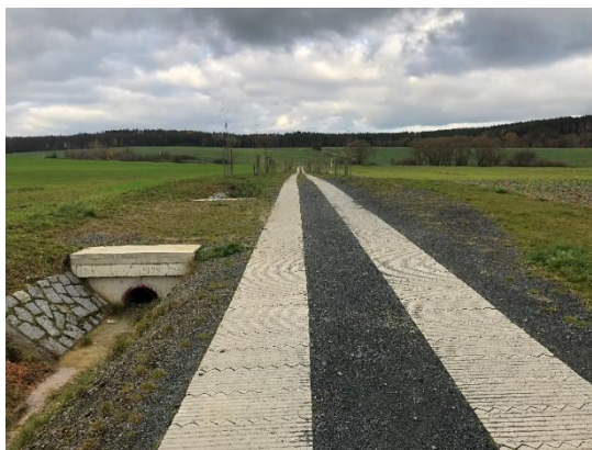
Obr. 6: HPC 1 včetně propustku, hospodářského sjezdu a výhybny
